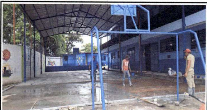
Foto 6: ya casi finalizando con el concreto dre la cancha.
