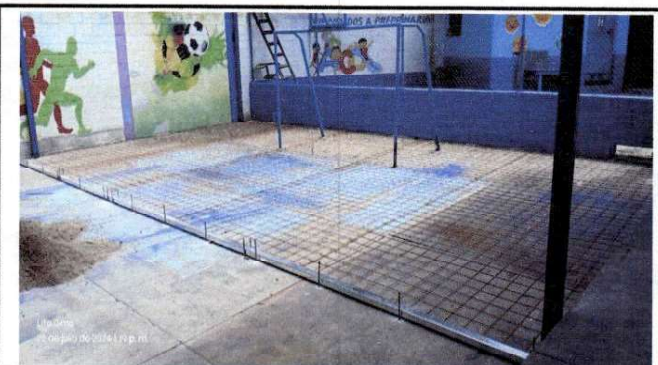
Foto 4: colocando electro malla para la reparacion del concreto de la cancha, levantado 5cm.
