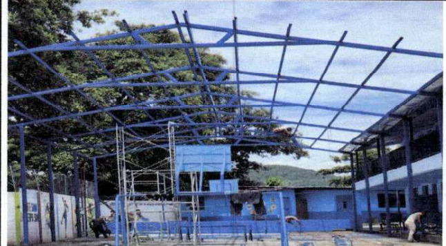
Foto 2: Trabajando estructura metalica para techo.
