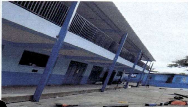
Foto 1: cimiento de costaneras para bases de la estructura del techo para la cnacha.
