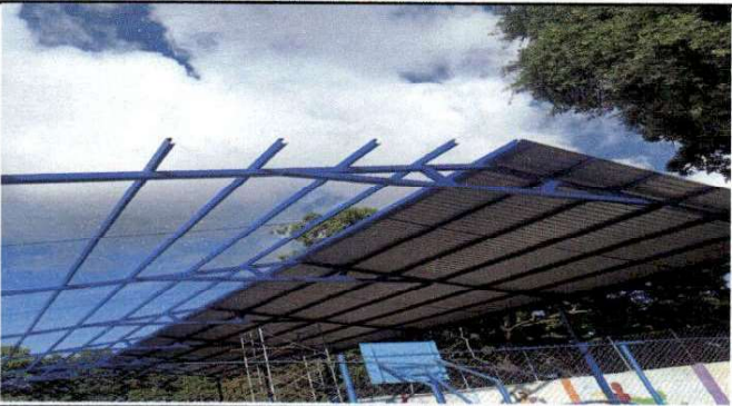
Foto 3: colocando laminas calibre 26 a la estructura metalica.
