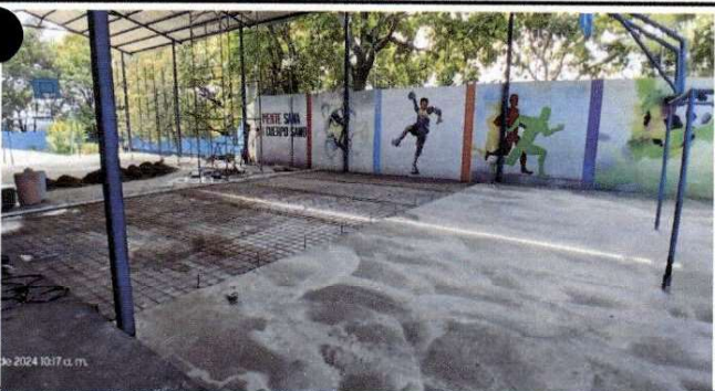
foto 5: Fundición de loza de 5 cmd para mejoramiento de cancha con electro malla.
