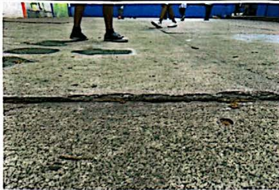
foto 1: Las grietas e irregulares han provocado accidentes donde los estudiantes han salido lesionados, estos hechos ocurridos durante receso y la clase de Educación física, motivo por el cual se realizarán
