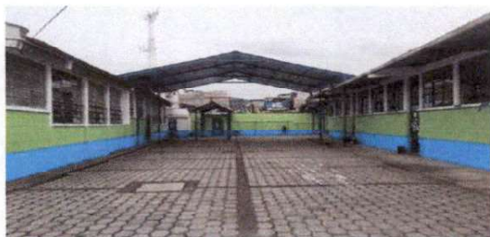
Foto 1: Remozamiento de Techo Patio (continuación estructura metálica)
