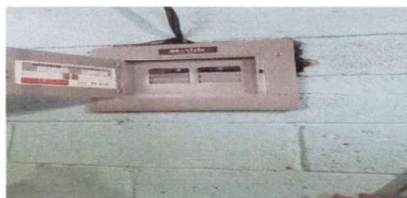
Foto 4: Mantenimiento del Sistema electrico de las aulas de Preprimaria
