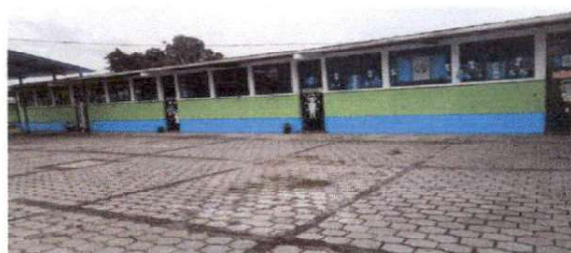
Foto 2: Pintura interior de las aulas de EODP Anexa EOUM No. 459 San Jose las Rosas
