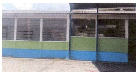
Foto 6: Pintura Interior en la pared que comunica el area de preprimaria con el area de primaria
