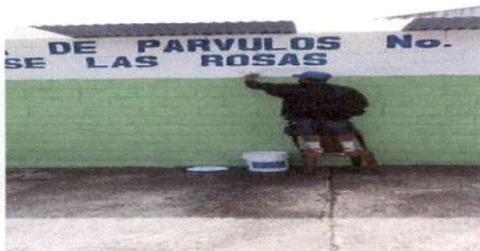
Foto 9: Pintura Exterior de la EODP ANEXA A EOUM No. 459 SAN JOSE LAS ROSAS
