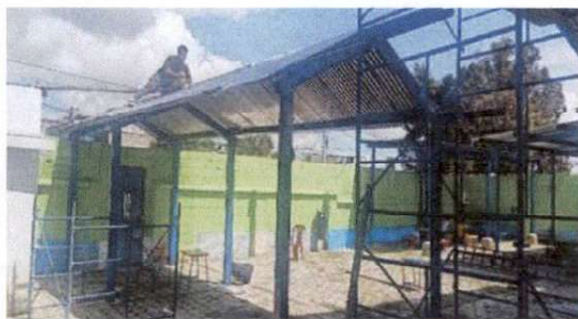
Foto 1: Remozamiento de Techo Patio (continuación estructura metálica)
