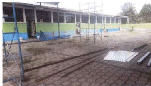
Foto 2: Remozamiento Techo ( este será el largo de la continuacion de la estructura metálica 300 metros) y pintura exterior
