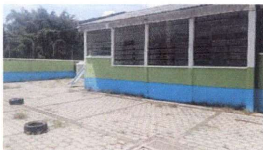
Foto 3: Pintura Interior frente de las 4 aulas de Preprimaria
