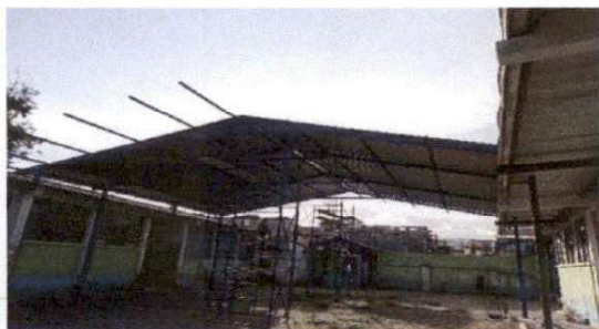
Foto 7: Estructura techad de la escolita de Preprimaria
