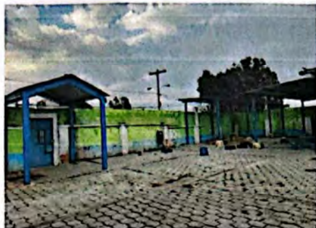
Foto7: Pintura Interior en la pared de la entrada de la escuelita de Preprimaria
