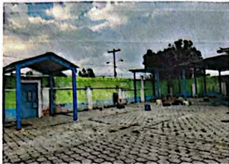
Foto 1: Remozamiento de Techo Patio (continuación estructura metálica)
