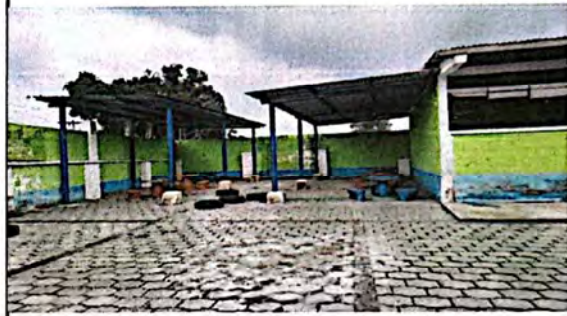
Foto 4: Pintura Interior en el area de mesitas
