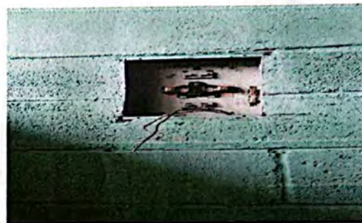
Foto 10: Mantenimiento del sistema eléctrico de las aulas de la escuelita de Preprimaria
