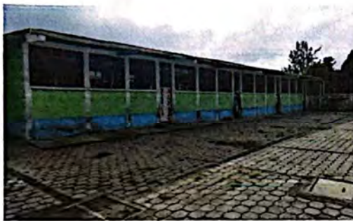
Foto 3: Pintura Interior frente de las 4 aulas de Preprimaria
