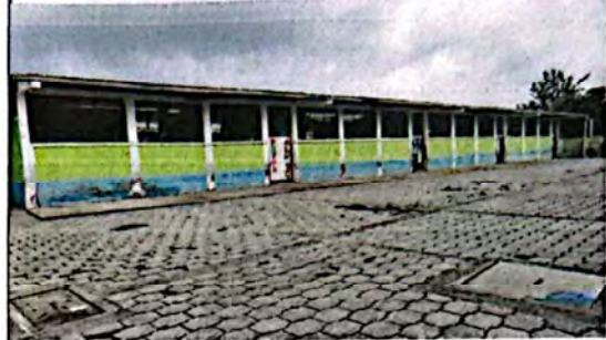
Foto 2: Remozamiento Techo (este será el largo de la continuación de la estructura metálica 300 metros)
