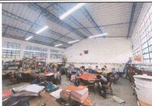
Foto1: Iluminación nueva en el aula de preparatoria B
