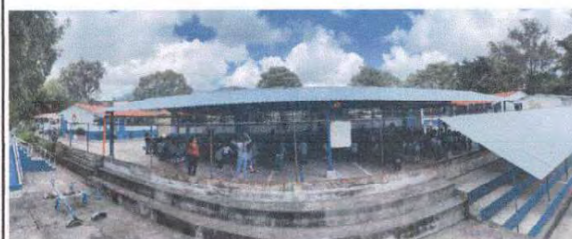
Foto 6: Vista panorámica de la ampliación del techo.
