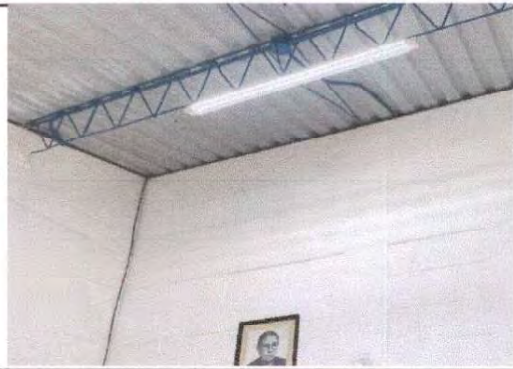
Foto 4: iluminación de dirección
