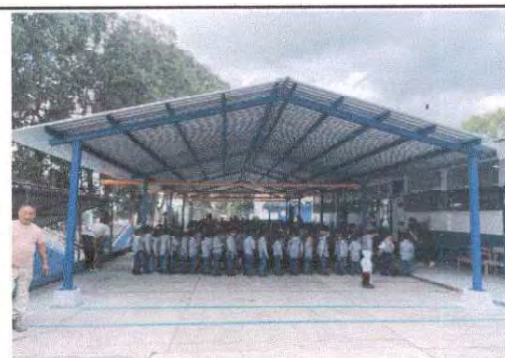
Foto 4: Vista desde otro ángulo el uso de la ampliación del techado
