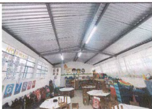
Foto 5: Aula iluminada Preparatoria E
