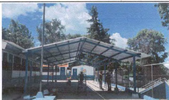
Foto 5: Instalación de lámina calibre 26 techo a dos aguas.
