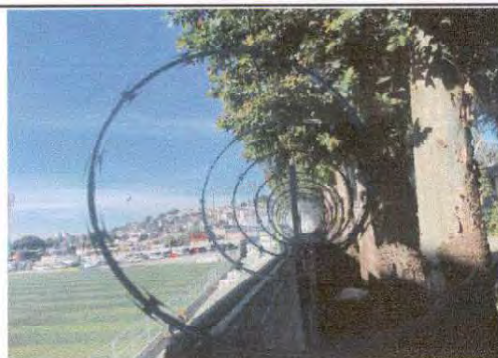
Foto 4: Instalación de Robbon Raizor de forma lineal ordenado
