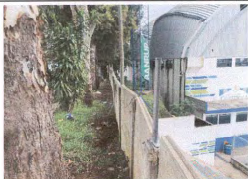
Foto 3: Seguimiento de la colocación de los tubos para sostener el Ribbon Raizor
