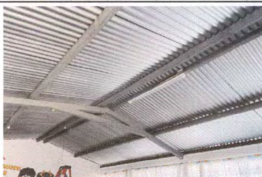
Foto 4: Instalación de bases y lamparas nuevas en el salón que tenía corto.
