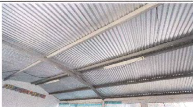
Foto 3: Corrección de corto, desinstalación de las lámparas que no encendían en el salón
