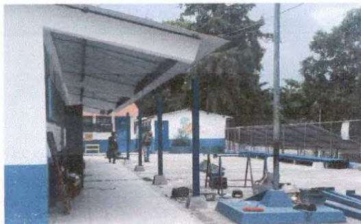
Foto1: Instalación de 5 bases que sostendran el techo
