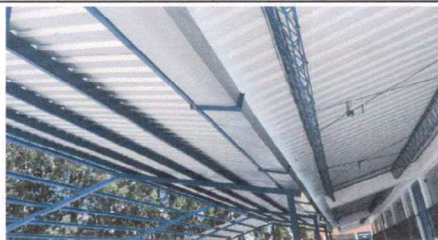
Foto 2: Instalación de canal para desfogar el agua con 4 caídas de agua establecidas.
