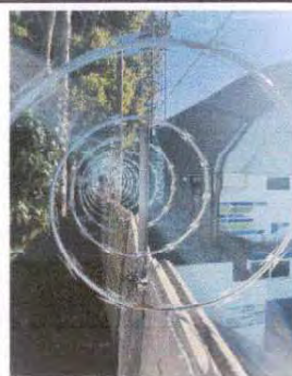
Foto 6: Finalización de la instalación de 72 metros lineales de Ribbon Raizor
