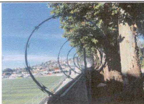
Foto 4: Instalación de Robbon Raizor de forma lineal ordenado
