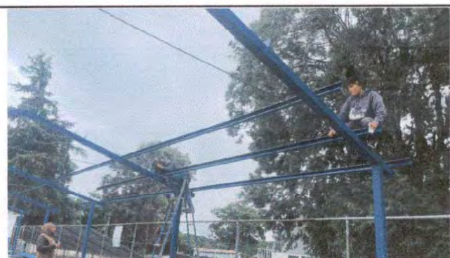
Foto 3: Instalación de las costaneras que serviran de sosten para la instalación de las láminas
