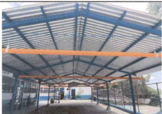
Foto 3: Colocación de bajadas pluviales
