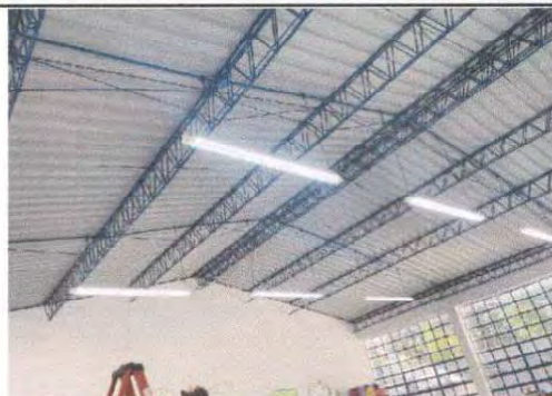
Foto 2: Instalacion correcta de la luz, cambio de bases y lámparas.
