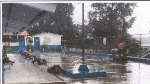
Foto 3: Fundición de las bases para las columnas que fueron protegidas debido a la lluvia que imperaba en el sector
