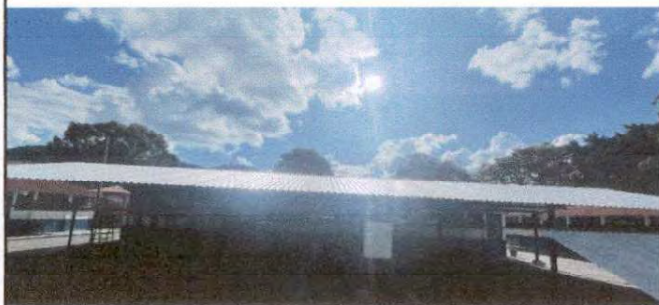
Foto1: Vista desde el área de juegos de la instalación de la lámina finalizada
