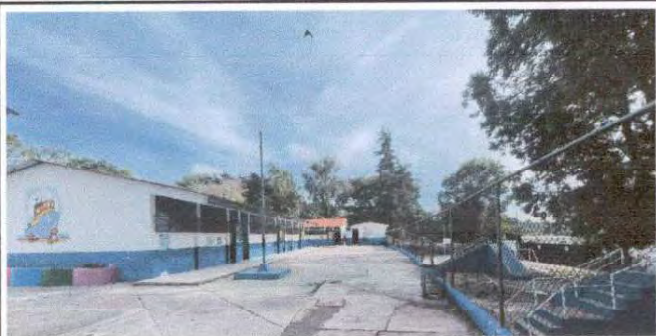
Foto1: Ampliación de techo sin ningun movimiento de tierras
