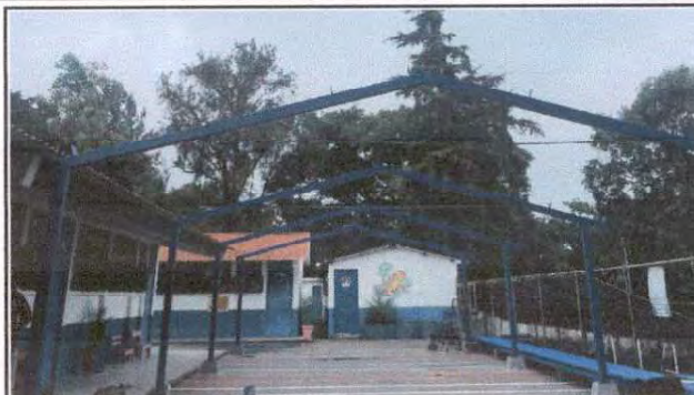
Foto 2: Instalación de los otros 5 paralaes y las tijas que sostendran el techo
