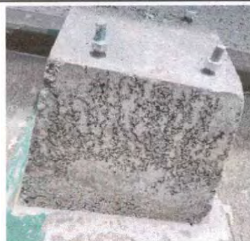
Foto 4: Desmontaje de las bases que sostendran las columnas, que seran talladas posteriormente para afinar los detalles.
