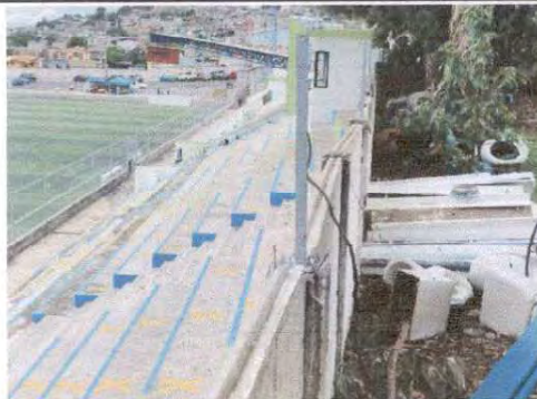
Foto 2: Instalación de bases para colocar el Ribbon Raizor
