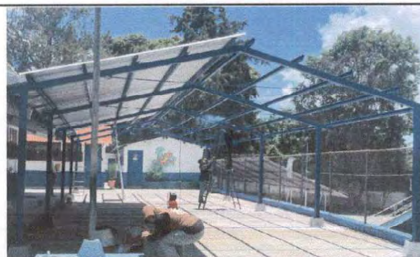
Foto 4: Finalización de pintura e inicio de la colocación de la lámina calibre 26.
