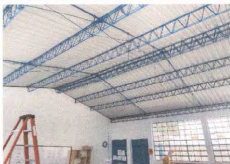
Foto1: Revisión de la corriente, en muchas aulas se encontro cortos en la instalación de las lámparas
