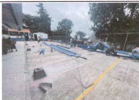
Foto 5: Soldadura de la armazon que servira para elevar la ampliación del techo, elaboración de las tijeras que seran colocados y llevaran el peso de la lámina.
