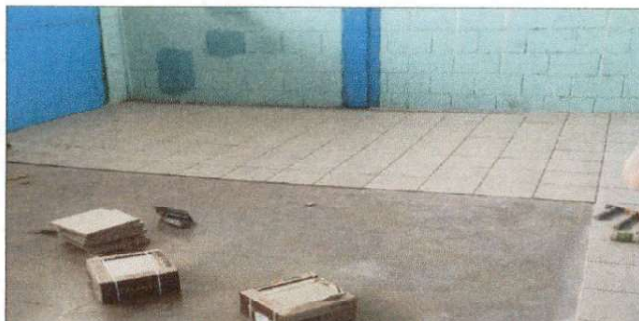
Foto 4: cambio de piso aula 3
