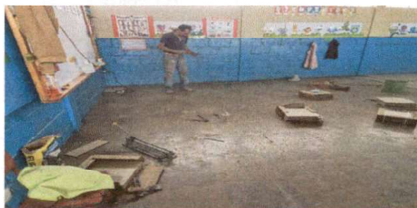
Foto 2: Instalacion de piso en aula 5
