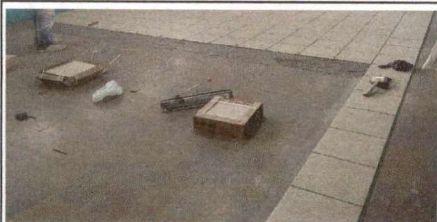
Foto 3: Instalación de piso aula 2
