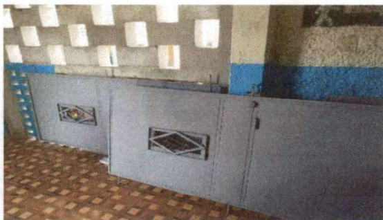
Foto 4: instalación de puerta
