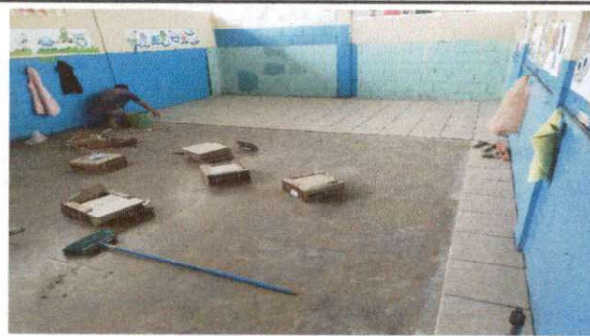
Foto 2: Instalacion de piso en aula 1
