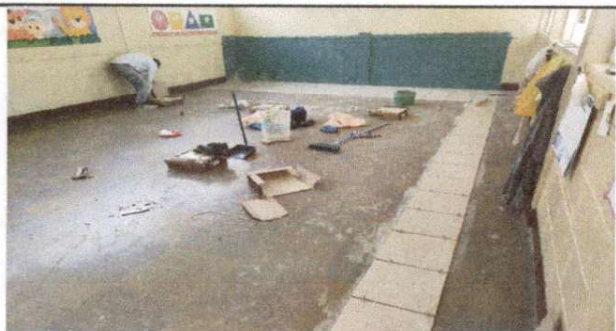
Foto 5: instalacion de piso aula 4
