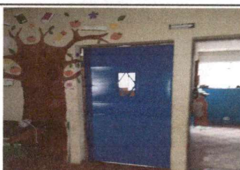
Foto 6: Instalacion de puerta
