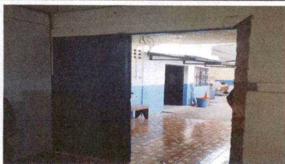
Foto 1: Instalacion de portón
