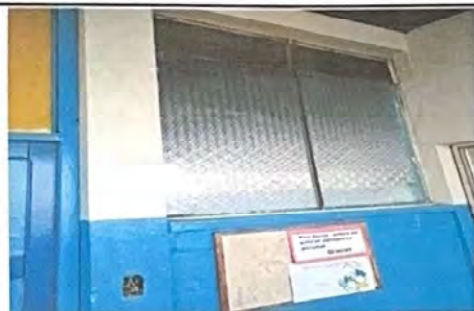
Foto 9: cambio de ventanas de aula aula 6
