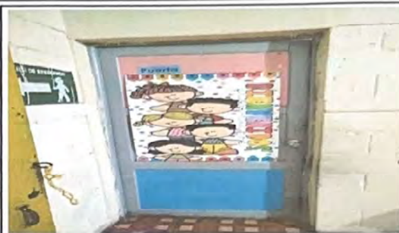
Foto 2: instalacion de puerta aula 1
