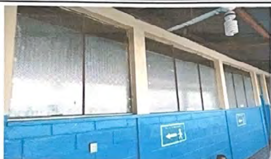
Foto7: instalacion de ventanas aula 5
