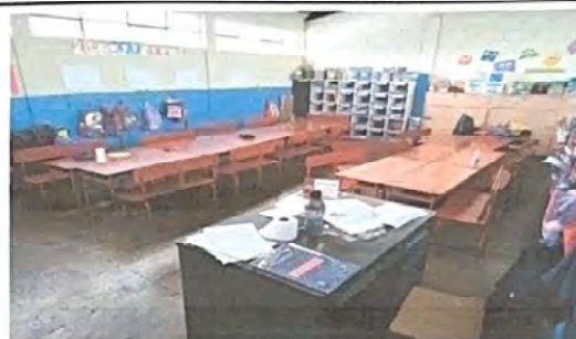
Foto 8: instalacion de piso aula 5
