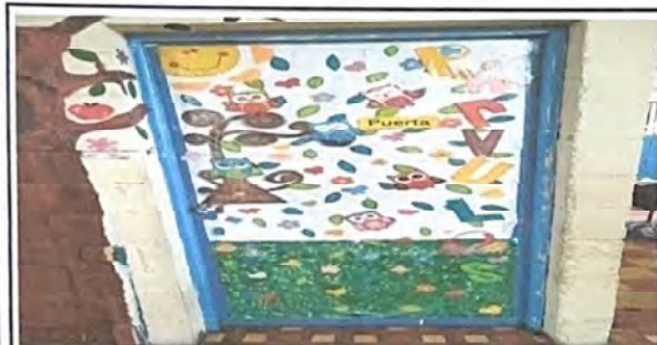
Foto 3: instalacion puerta aula 2
