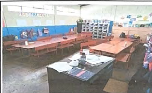
Foto 10: cambio de piso de aula 6
