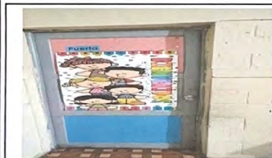
Foto 5: instalacion de puerta aula 4
