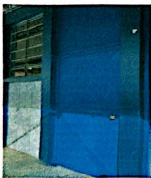
Foto 5: mantenimietno de puertas
