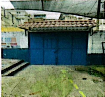
Foto 1: colocacion de techado en el porton
