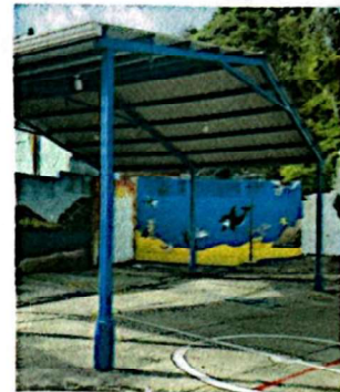
Foto 4: mantenimiento de estructura
