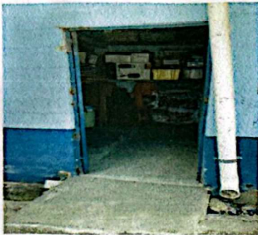
Foto 3: colocacion de piso y estanteria en bodega
