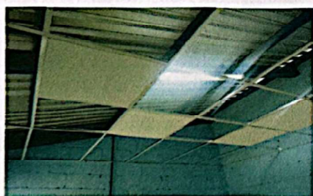
Foto 5: colocacion de cielo falso
