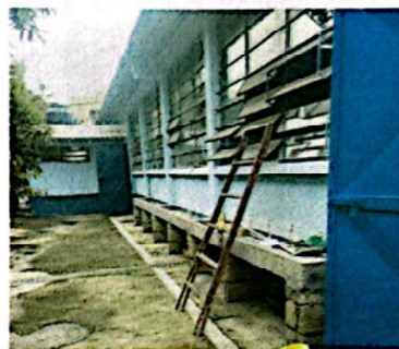
Foto 4: colocacion de pilitas
