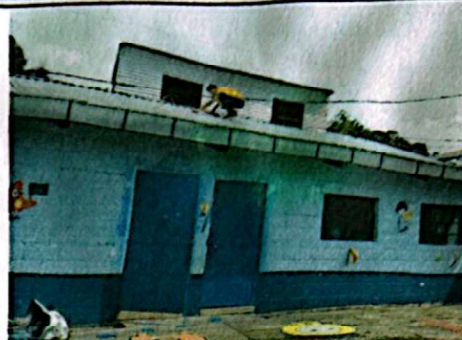
Foto 2: colocacion de canaleta en techado y goteras
