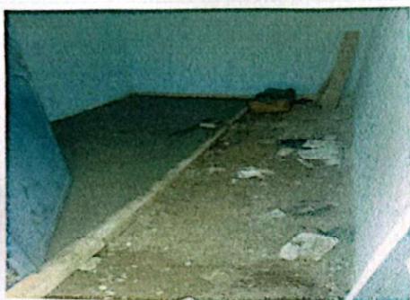
Foto 3: colocacion de piso y estanteria en bodega
