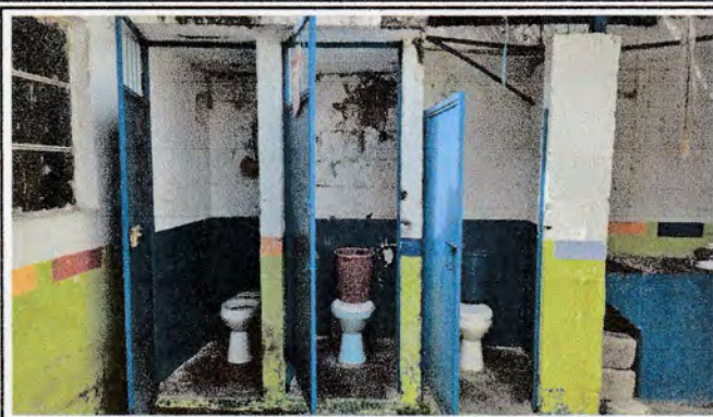
Foto 2: REMOZAMIENTO DE SERVICIOS SANITARIOS.
