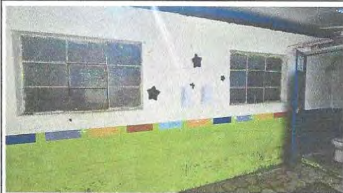
Foto 9: SUMINISTRO Y COLOCACION DE VENTANAS DE PVC
