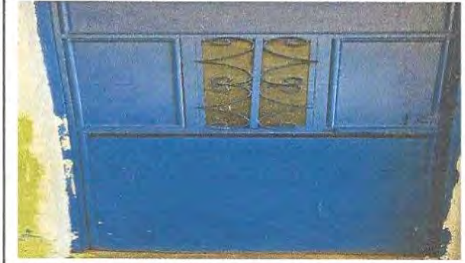
Foto 8: SUMINISTRO Y COLOCACION DE PUERTA DE METAL EN AULA
