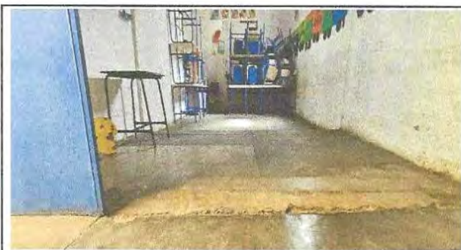
Foto 11: CORTE Y NELACION DE PISO DE CONCRETO EN AULA
