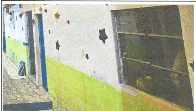
Foto 10: SUMINISTRO Y COLOCACION DE VENTANAS DE PVC PARA AULAS DEL ESTABLECIMIENTO EDUCATIVO.
