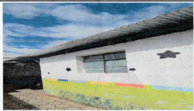
Foto 6: COLOCACION DE CANAL TROQUELADO
