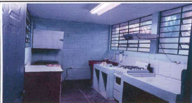
Foto 5: REMODELACION DE COCINA
