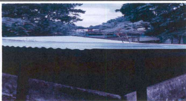
Foto 3: REMODELACION DE TECHO DE PASILLO DE ENTRADA
