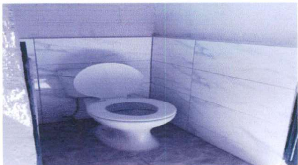
Foto1: SUSTITUCION DE BAÑOS
