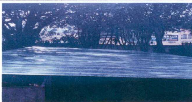
Foto 6: REMODELACION DE TECHO DE COCINA
