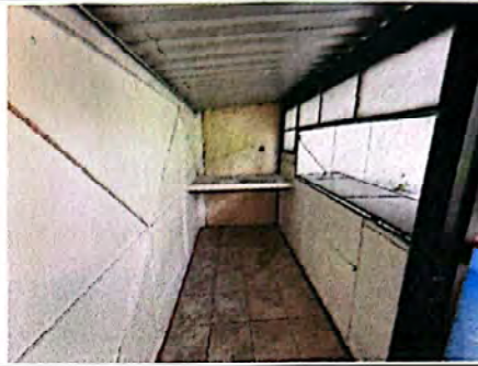
Foto 8: Mejoras en cocina, puesta de piso + pintura + cambio de techo.
