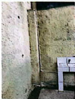
Foto 7: Suministro e instalación de tubería de agua potable.
