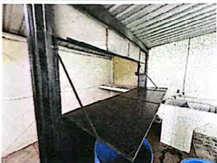
Foto 9: Modificación en ventana de cocina, dejándola tipo caseta.
