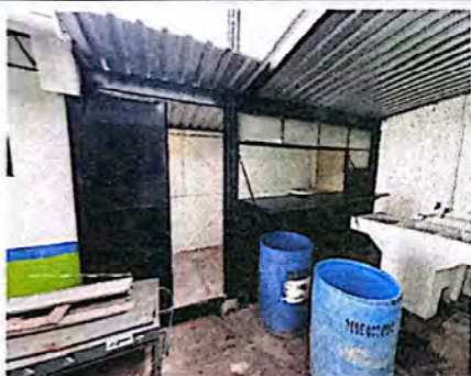
Foto 9: Mantenimiento de estructura metálica en cocina.
