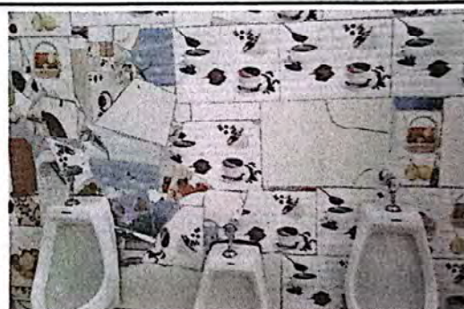
Foto 10: Suministro e instalación de llave tipo push en mijitorios.
