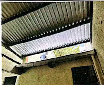
Foto 8: Suministro e instalación de techo en patio.
