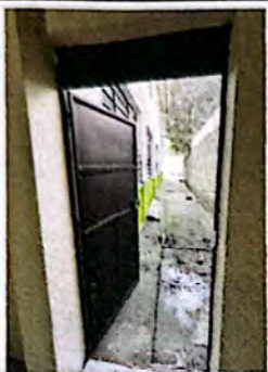
Foto 7: Mantenimiento de puerta incluye lijado y pintura.
