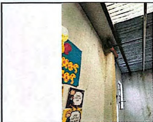
Foto 3: Debido a las malas prácticas al momento de la instalación del techo el canal y las bajadas pluviales se tienen problemas de filtración.
