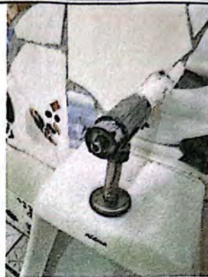
Foto 8: Los mingitorios no cuentan con llaves de tipo push en funcionamiento.
