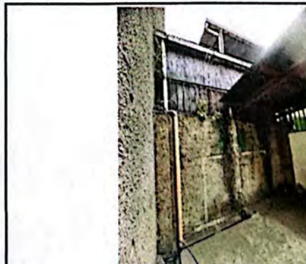
Foto 6: Se tienen problemas de humedad debido a la falta de techo y canal pluvial
