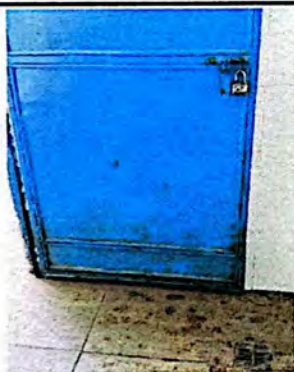
Foto 9: Las puertas principales en los baños presentan oxidación.
