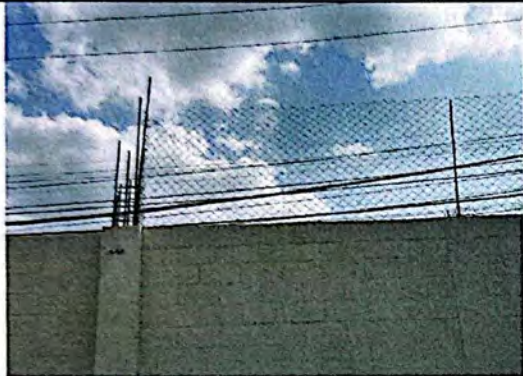
Foto 7: Se han tenido problemas de robos en la escuela, por lo que se solicita la colocación de malla en la parte del muro de la cancha, como mínimo que cuente con 1 metro de altura.
