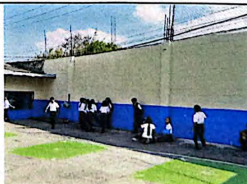
Foto 6: Debido a la cantidad de alumnos y que el único punto de acceso y salida es una puerta de 1 metro de ancho se propone la realización de una salida de emergencia en el área de cancha.
