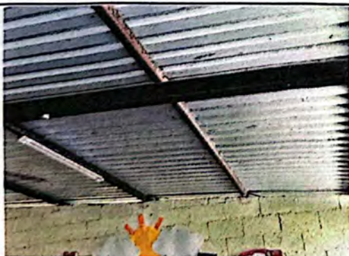
Foto 5: Se puede apreciar el oxido que presenta la estructura de soporte del techo en el Bloque D del establecimiento.
