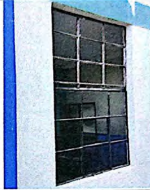
Foto 8: La ventana de la cocina no cuenta con vidrios y se ha conformado con 2 marcos metálicos antiguos en malas condiciones.
