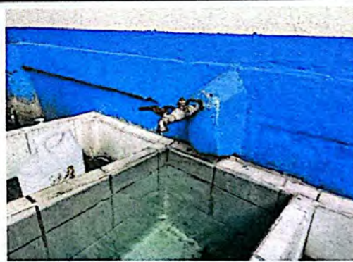
Foto 10: Los chorros pertenecientes a las pilas se encuentran en malas condiciones.
