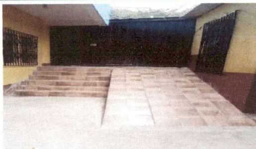
Foto 1: Area de ingreso donde se diseña una rampa para sustituir las gradas y facilitar el ingreso de los alumnos.
