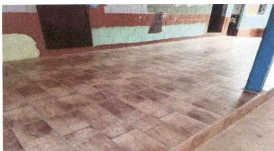
Foto 3: Patio externo de aulas que cambiado por piso ceramino.
