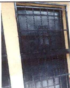
Foto 5: reinstalacion de reja en puerta retirada por diseño de rampa
