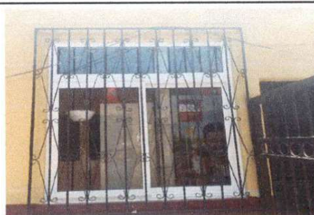
Foto 6: Ventana de el ambiente utilizado para dirección cambiada por una Ventana totalmente nueva de PVC.
