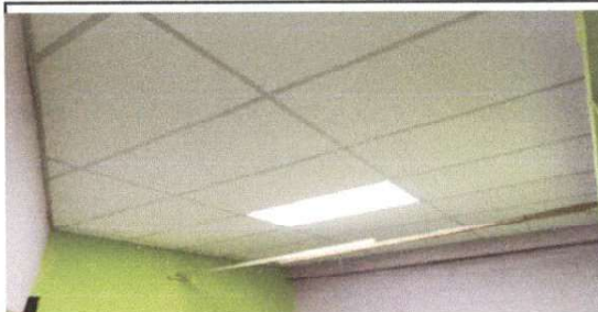
Foto 4: instalacion eléctrica, iluminacion y cielo falso de salon que antes no tenía iluminacion
