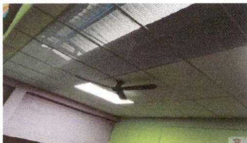
Foto 5: siguiente salon con cielo falso, iluminacion, instalacion electrica y ventilacion
