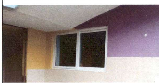
Foto 6: cambio de ventana
