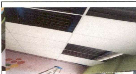
Foto 4: Techo de salon al cual se le colocara techo falso para mejorar el ambiente dentro del salon y reducir el calor ocasionado por el techo de lamina. Tambien instalacion de energia electrica
