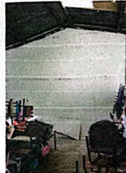
Foto 4: Armado de Muros divisorios prefabricados.
