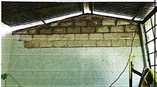
Foto 3: Levantado de block en Mojinetes.
