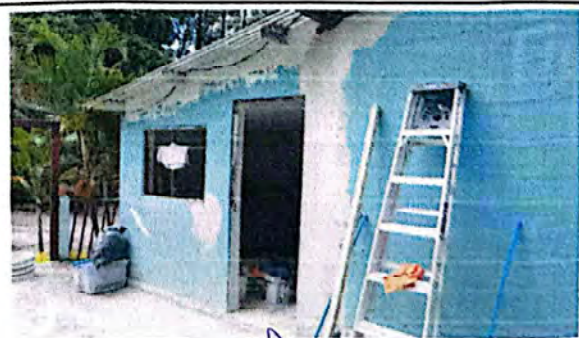
Foto 6: Trabajos de resane de muros en cocina y cambio de techo de lámina.
