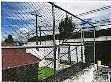
Foto 1: Suministro e instalación de malla.
