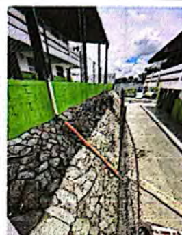
Foto 8: Trabajos de mantenimiento a muro de piedra.
