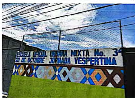
Foto 4: Suministro e instalación de malla + mantenimiento a tubería en muro principal.
