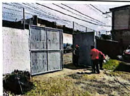
Foto 6: Trabajos de mantenimiento a portón en parqueo.
