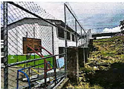
Foto 3: Suministro e instalación de malla + mantenimiento de tubos de soporte.
