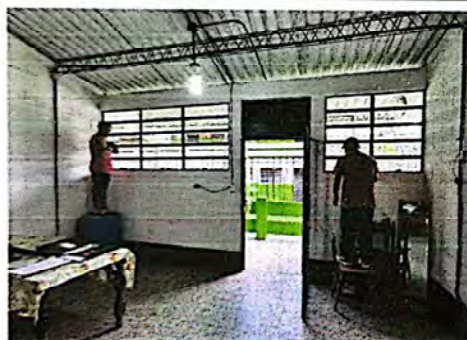
Foto 9: Trabajos de mantenimiento en ventanas.
