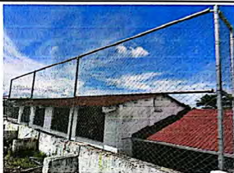
Foto 2: Suministro e instalación de malla + mantenimiento de tubos de soporte.
