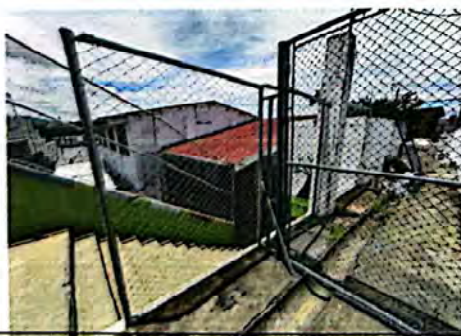
Foto 5: Suministro e instalación de puerta de malla con tubería.
