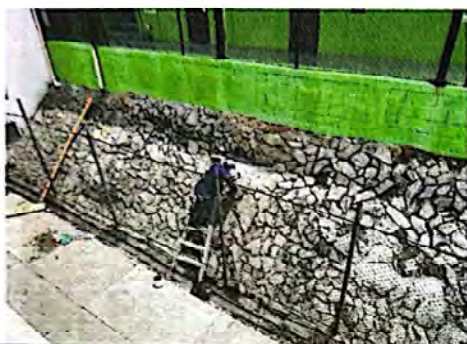
Foto 7: Trabajos de mantenimiento a muro de piedra.
