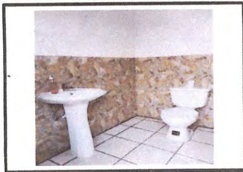
Foto 3: BAÑO TERMINADO, CON SU PISO CERÁMICO NUEVO Y EL INODORO NUEVO A NIVEL DE LOS NIÑOS PEQUEÑOS DE CUATRO AÑOS, DEL MÓDULO "C".
