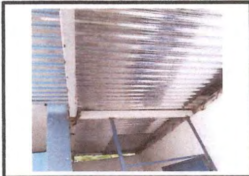
Foto 4: CAMBIO DE LÁMINAS NUEVAS A LA BODEGA.
