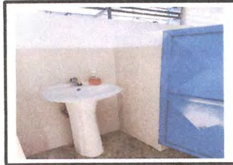
Foto 4: CAMBIO DE LAVAMANOS DEL BAÑO DE NIÑAS DEL MÓDULO "A" DE LA PLANTA BAJA Y PINTURA DE LAS PUERTAS.
