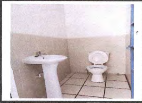
Foto1: BAÑO TERMINADO DEL MÓDULO "C".
