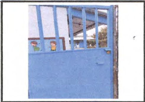
Foto 1: PUERTA FORMAL NUEVA CON TECHITO Y CAMBIO DE CHAPA.
