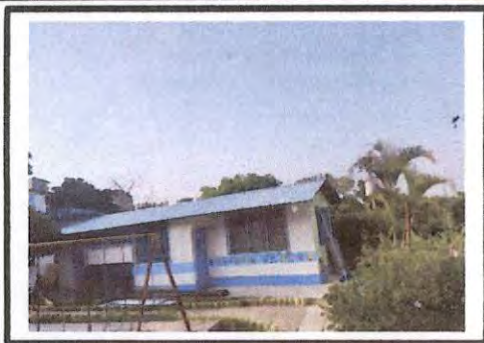
Foto 1: TECHO NUEVO Y COSTANERAS BIEN PINTADAS EN EL ÁREA DE LA CLÍNICA.
