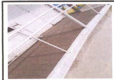
Foto 4: RAMPA TERMINADA Y MANTENIMIENTO DE PASAMANOS.
