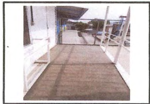
Foto 3: FUNDICIÓN DE RAMPA.
