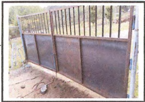
Foto 3: INSTALACIÓN DEL NUEVO PORTÓN FORMAL.
