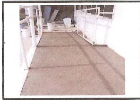
Foto 3: FUNDICIÓN DE RAMPA EN PROCESO.
