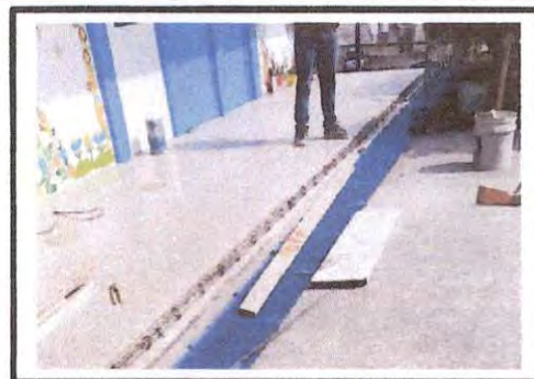
Foto 2: DESMONTAJE DE BORDILLOS EN MAL ESTADO Y QUEBRADOS.
