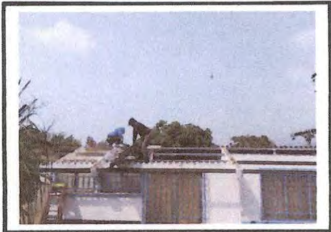
Foto 1: DESMONTAJE DEL TECHO DURALITA DEL ÁREA DE LA CLÍNICA.
