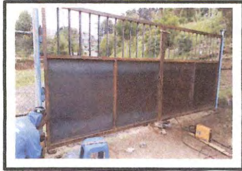
Foto 4: INSTALACIÓN DEL NUEVO PORTÓN FORMAL.
