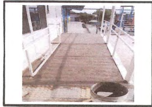
Foto 2: DESMONTAJE DE DUELAS E INICIO DE FUNDICIÓN DE RAMPA EN EL AULA PREFABRICADA.
