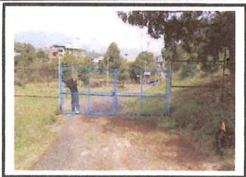
Foto 1: DESMONTAJE DEL PORTÓN DE MALLA ANTIGUO.
