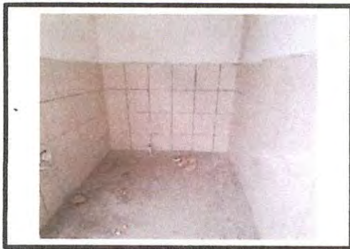
Foto 3: COLOCACIÓN DE PISO CERÁMICO Y AZULEJO EN LAS PAREDES DEL BAÑO DEL MÓDULO "C".
