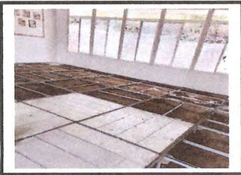
Foto1: DESMONTAJE DE DUELAS EN EL AULA PREFABRICADA.
