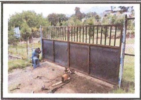
Foto 5: INSTALACIÓN DEL NUEVO PORTÓN FORMAL.
