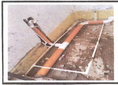
Foto 2: INSTALACIÓN DE TUBERÍA PARA EL PASO DEL AGUA DEL BAÑO DEL MÓDULO "C".
