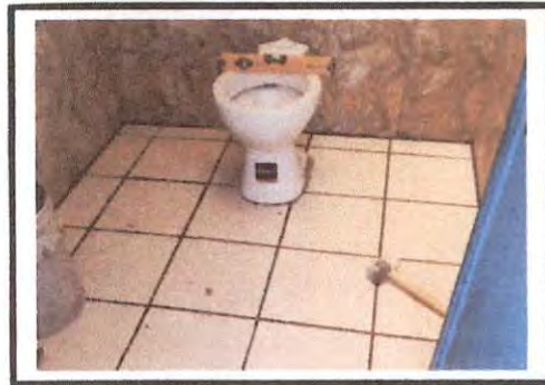
Foto 2: CAMBIO DE PISO CERÁMICO Y CAMBIO DE INODORO EN UNO DE LOS BAÑOS DEL MÓDULO "C".
