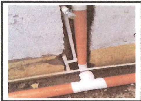
Foto 1: INSTALACIÓN DE DRENAJE PARA EL BAÑO DEL MÓDULO "C".
