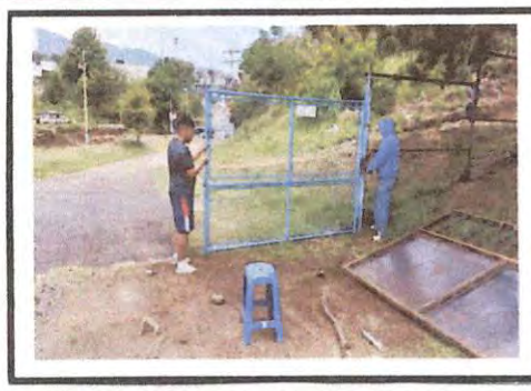
Foto 2: DESMONTAJE DEL PORTÓN DE MALLA ANTIGUO.
