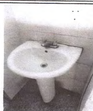
Foto 26: Los lavamanos del Módulo A - Planta Baja, serán reemplazados por nuevos, en la actualidad se encuentran deteriorados y sufren de obstrucción en el sifón.
