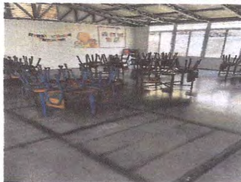
Foto 2: Se llevará a cabo todo el levantamiento de duelas en mal estado y se fundirá 62 metros cuadrados de piso en el aula, se colocará piso cerámico.
