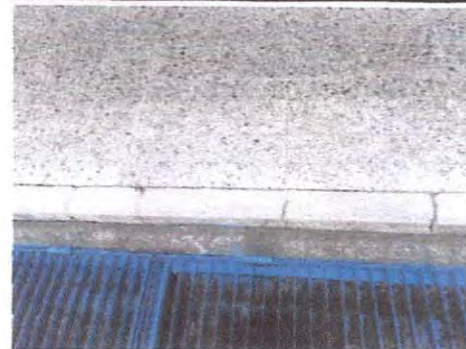
Foto 18: Reparación de bordillos quebrados y astillados de la segunda parte del Módulo B - Planta Baja.
