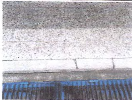
Foto 17: Reparación de bordillos quebrados y astillados de la primera parte del Módulo B - Planta Baja.
