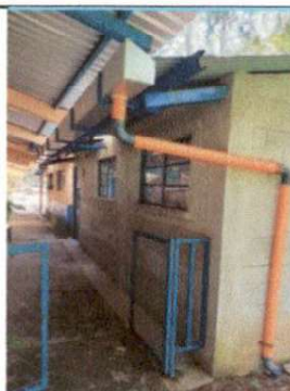
Foto 4: SUMINISTRO E INSTALACIÓN DE CANALETA CON BAJADA DE AGUA PLUVIALES
