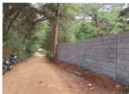
Foto 6: SUSTITUCIÓN DE MURO PERIMETRAL
