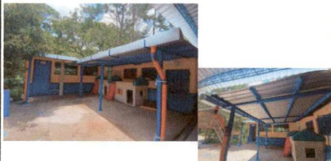
Foto 3: AMPLIACIÓN DE TECHO
