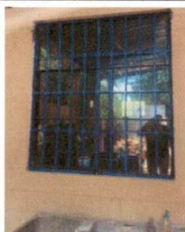
Foto 5: MANTENIMIENTO DE BALCONES DE COCINA
