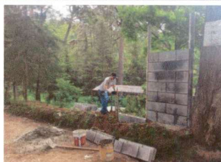
Foto 6: SUSTITUCIÓN DE MURO PERIMETRAL
