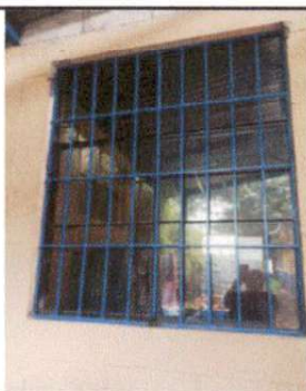
Foto 5: MANTENIMIENTO DE BALCONES DE COCINA
