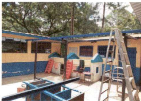
Foto 3: AMPLIACIÓN DE TECHO
