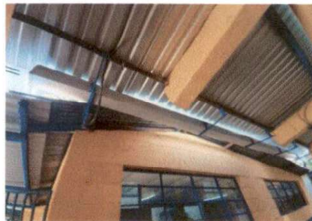
Foto 4: SUMINISTRO E INTALACIÓN DE CANELETA CON BAJADA DE AGUA PLUVIALES
