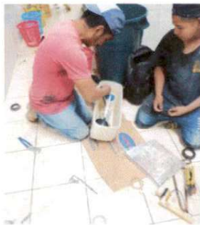
Foto1: MÓDULO DE BAÑOS
