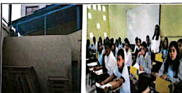
Foto 6: Se necesita remodelar el acceso al segundo nivel, cambiando las gradas que se encuentran detrás de esta pared y construir las gradas a la pared lateral, esto facilitará la fluidez del alumnado, se necesita quitar los block de vidrio y colocar rejillas en la fila pegada al techo para lograr ventilación.
