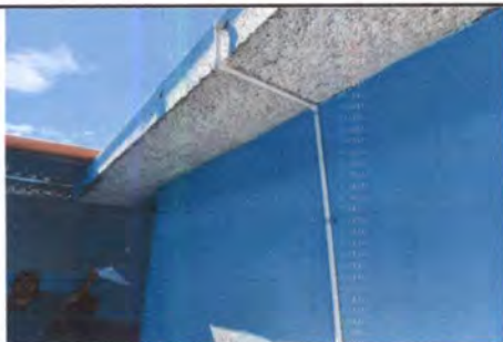
FOTO 11: INSTALACIÓN DE TUBERÍA PVC DE AGUA POTABLE
