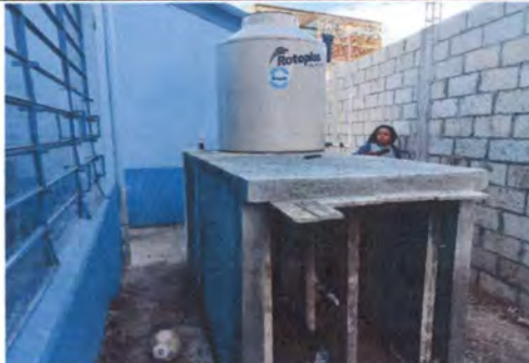
FOTO 8: SUSTITUCIÓN DE TINACO INCLUYENDO BASE
