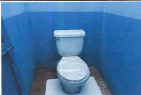
FOTO 7: SUSTITUCIÓN DE INODOROS
