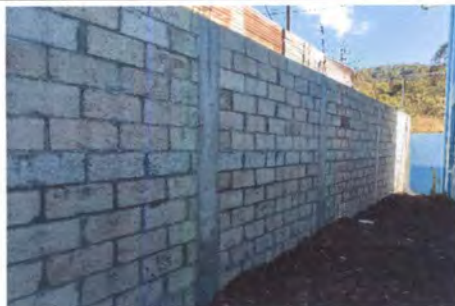
FOTO 9: REPARACIÓN DE MURO PERIMETRAL
