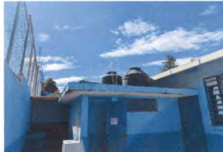
FOTO 10: REINSTALACIÓN DE TINACO
