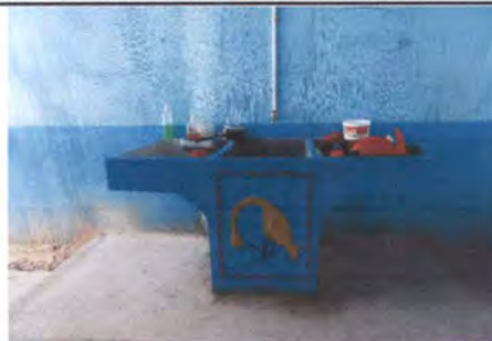
FOTO 12: INSTALACIÓN DE PILA DE CONCRETO DE 2 LAVADEROS
