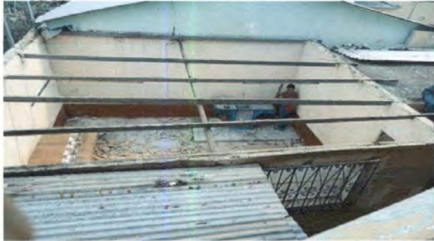
Foto 1: DESMONTAR EL TECHO COMPLETO DE LÁMINA DE COCINA
