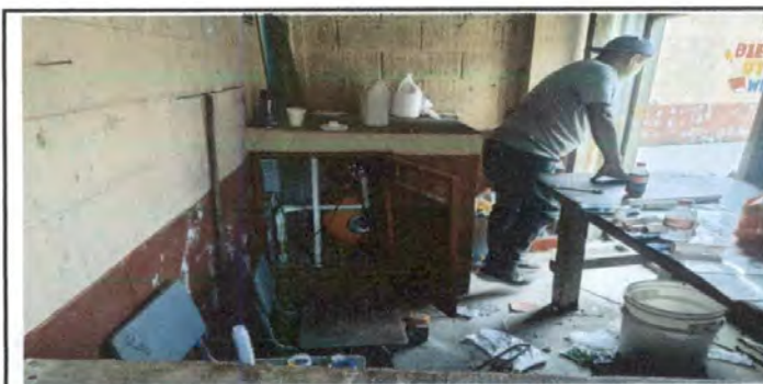
Foto 5: CAMBIO E INSTALACIÓN DE BOMBA NUEVA
