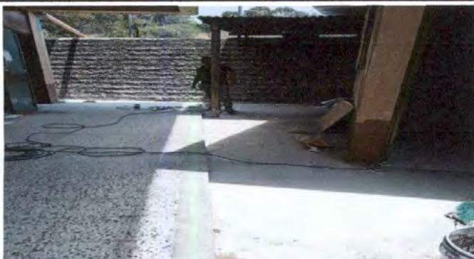
Foto 3: REPARACIÓN DE PLANCHA DE CONCRETO DE PATIO AL LADO DE LA COCINA CON DESNIVEL
