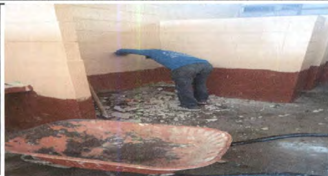
Foto 1: CAMBIO DE MINGITORIO DE CONCRETO EN MAL ESTADO
