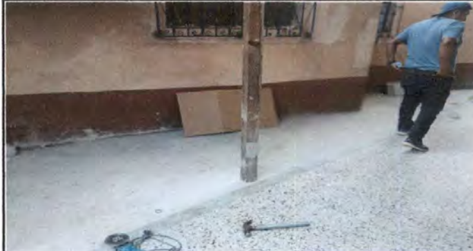
Foto 4: REPARACIÓN DE PLANCHA DE CONCRETO DE PATIO AL LADO DE LA COCINA CON DESNIVEL
