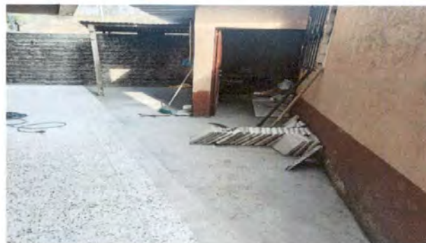
Foto 2: MANTENIMIENTO DE PUERTA DE COCINA: LIJADO, CEPILLADO Y PINTURA
