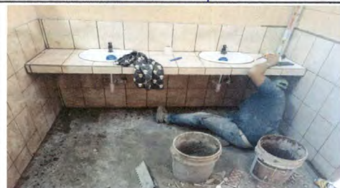
Foto 2: INSTALACIÓN DE AZULEJO EN LAVAMANOS
