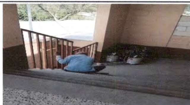
Foto 4: MATENIMIENTO DE BARANDAS EN GRADAS
