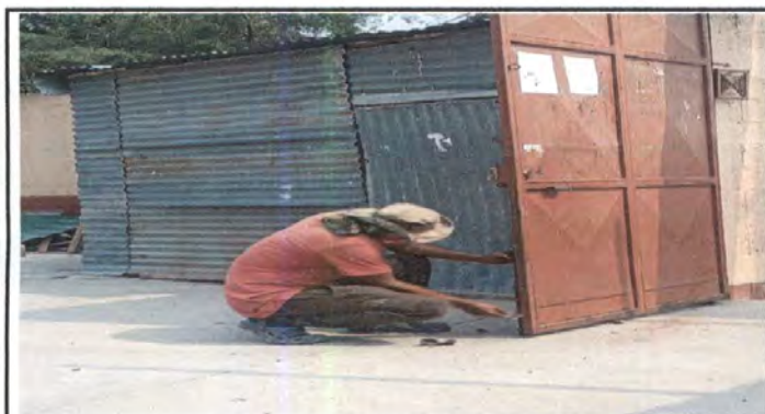
Foto 3: MANTENIMIENTO DE PORTÓN, PUERTA SEGUNDO NIVEL CON CHAPA YALE : LIJADO, CEPILLADO Y PINTADO
