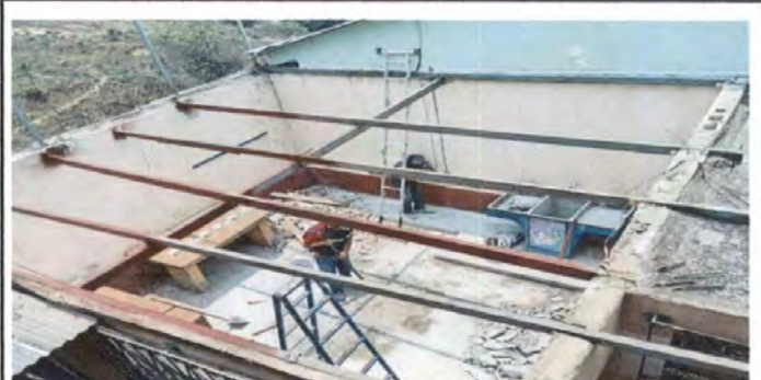
Foto 4: MANTENIMIENTO DE COSTANERAS: LIJADO Y PINTADO
