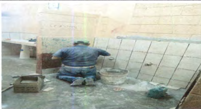
Foto 5: INSTALACIÓN DE AZULEJO EN BAÑOS
