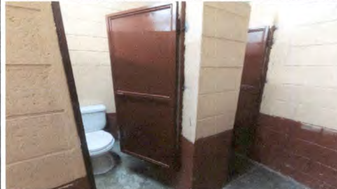
Foto 2: MANTENIMIENTO DE PUERTAS DE METAL DE BAÑO INTERIOR PRIMARIA Y EXTERIOR PREPRIMARIA
