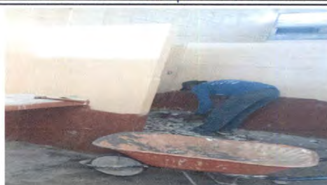
Foto 2: CAMBIO DE MINGITORIO DE CONCRETO EN MAL ESTADO
