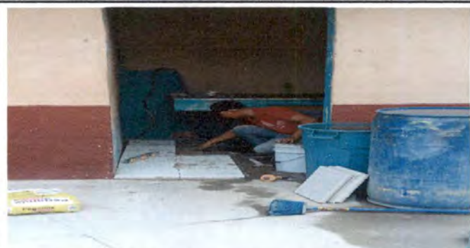
Foto 6: INSTALACIÓN DE PISO GRANITO EN ÁREA DE LA PILA
