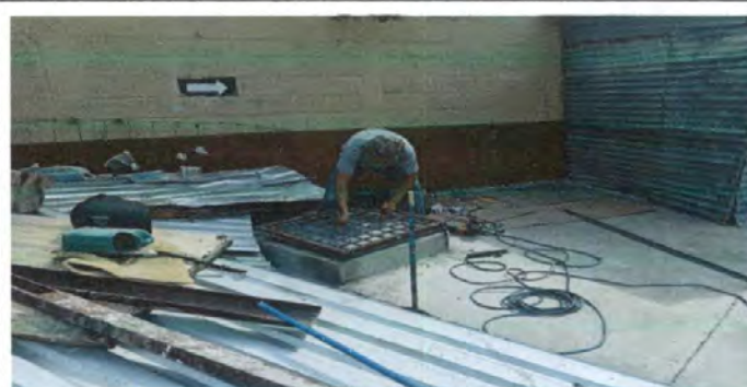
Foto 4: FABRICACIÓN E INSTALACIÓN DE TAPADERA DE CISTERNA
