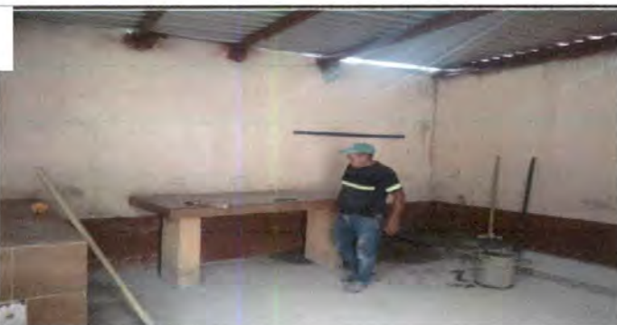
Foto 5: INSTALACIÓN DE LÁMINAS EN EL TECHO DE LA COCINA
