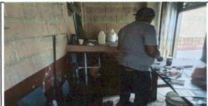
Foto 6: CAMBIO E INSTALACIÓN DE BOMBA NUEVA
