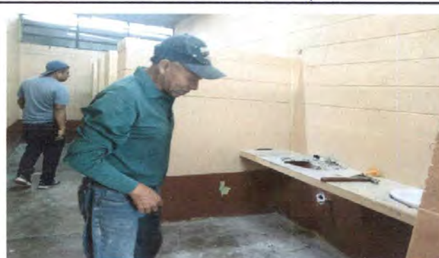
Foto 2: SUSTITUCIÓN DE LAVAMANOS BAÑOS DE NIÑAS Y NIÑOS
