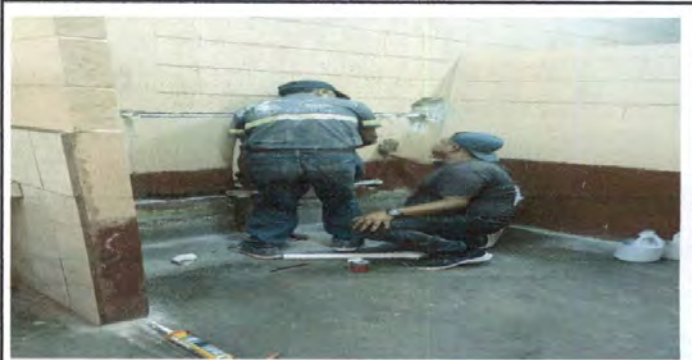
Foto 2: INSTALACIÓN DE MINGITORIO EN BAÑOS DE NIÑOS
