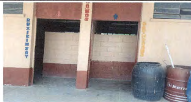
Foto 6: ANTENIMIENTO DE PUERTAS DE BAÑO DE PRIMARIA Y PREPRIMARIA: LIJADO, CEPILLADO Y PINTURA
