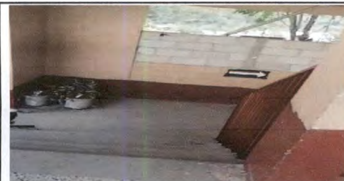
Foto 3: MATENIMIENTO DE BARANDAS EN GRADAS
