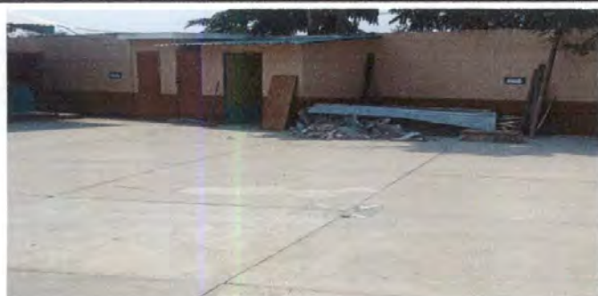
Foto 5: MANTENIMIENTO DE PUERTAS DE BAÑO DE PRIMARIA Y PREPRIMARIA: LIJADO, CEPILLADO Y PINTURA
