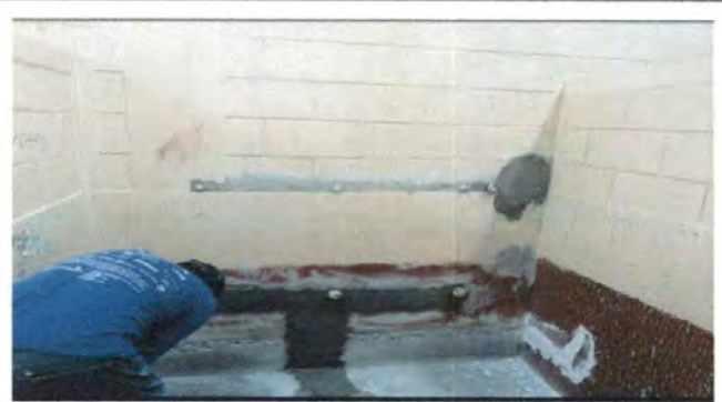
Foto 4: INSTALACIÓN DE TUBERIA EN BAÑOS
