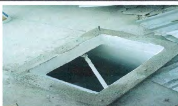
Foto 2: VACIADO E IMPERMEABILIZACIÓN DE CISTERNA
