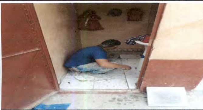
Foto 3: INSTALACIÓN DE PISO GRANITO EN BAÑO DE MAESTRAS
