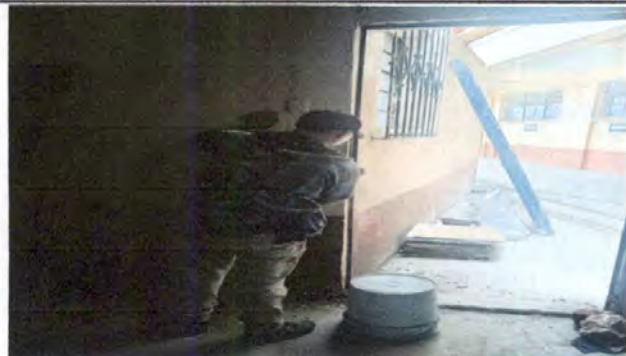
Foto1: MANTENIMIENTO DE PUERTA DE COCINA: LIJADO, CEPILLADO Y PINTURA
