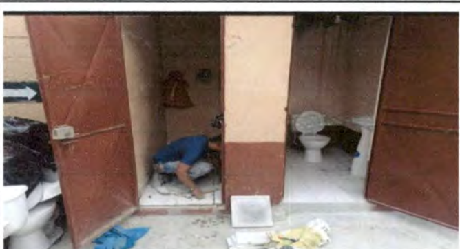
Foto 4: INSTALACIÓN DE PISO GRANITO EN BAÑO DE MAESTRAS
