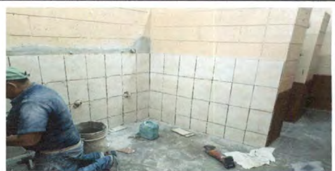
Foto 6: INSTALACIÓN DE AZULEJO EN BAÑOS
