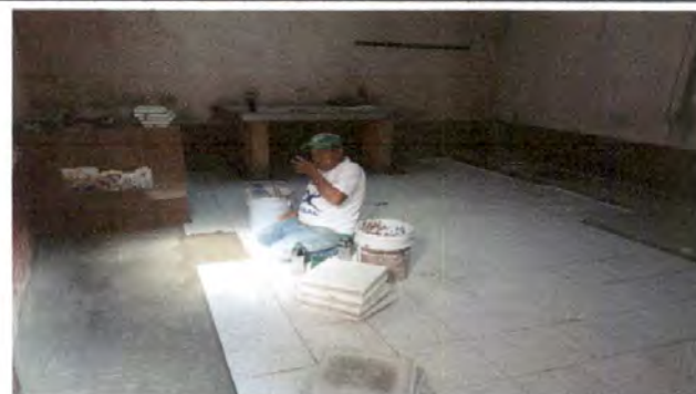
Foto 4: EVANTADO DE AZULEJO Y TORTA, INSTALACIÓN DE PISO GRANITO
