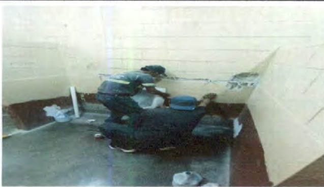
Foto 1: INSTALACIÓN DE MINGITORIO EN BAÑOS DE NIÑOS
