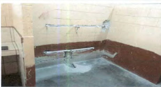
Foto 3: INSTALACIÓN DE TUBERIA EN BAÑOS
