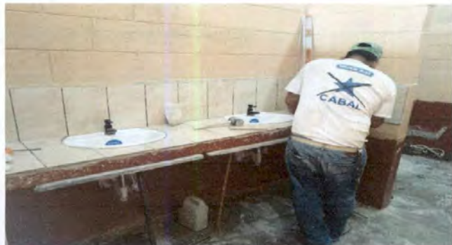
Foto 1: INSTALACIÓN DE AZULEJO EN LAVAMANOS
