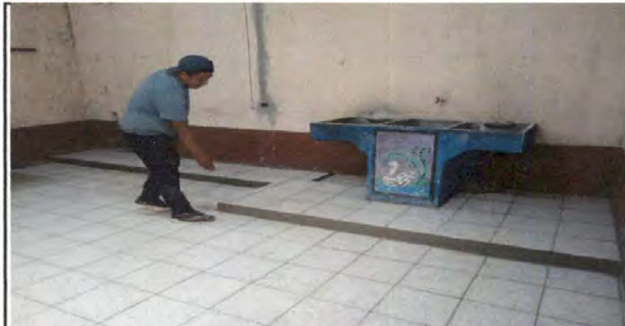
Foto 6: SUSTITUCIÓN DE PISO CERÁMICO POR GRANITO EN LA COCINA
