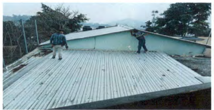
Foto 2: DESMONTAR EL TECHO COMPLETO DE LÁMINA DE COCINA
