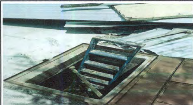
Foto 1: VACIADO E IMPERMEABILIZACIÓN DE CISTERNA
