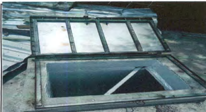
Foto 3: FABRICACIÓN E INSTALACIÓN DE TAPADERA DE CISTERNA
