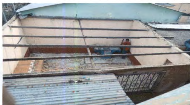
Foto 3: LEVANTADO DE AZULEJO Y TORTA, INSTALACIÓN DE PISO GRANITO
