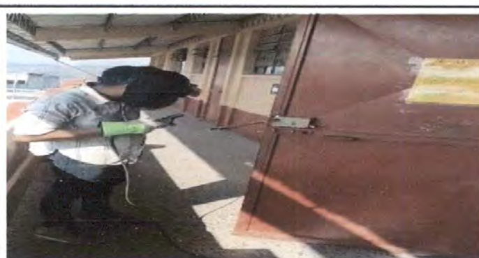
Foto 4: MANTENIMIENTO DE PORTÓN, PUERTA SEGUNDO NIVEL CON CHAPA YALE : LIJADO, CEPILLADO Y PINTADO
