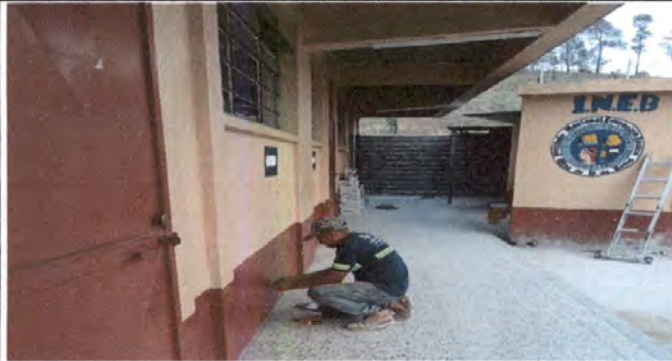
Foto1: CAMBIO DE TOMACORRIENTES
