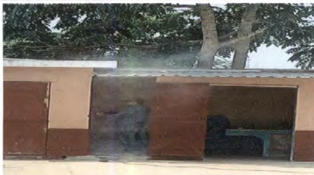
Foto 1: MANTENIMIENTO DE PUERTAS DE METAL DE BAÑO INTERIOR PRIMARIA Y EXTERIOR PREPRIMARIA
