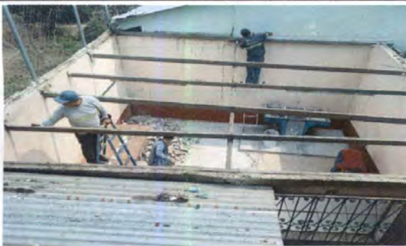
Foto 3: MANTENIMIENTO DE COSTANERAS, LIJADO Y PINTURA
