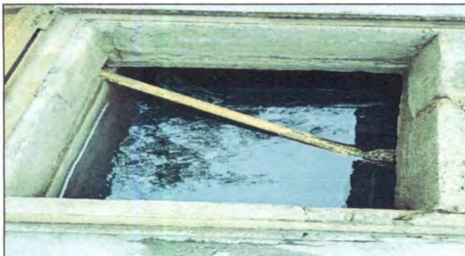
Foto 61: Limpieza y pintar con impermeabilizante la superficie de la cisterna de concreto en el patio con medida de 4x3.6mts y colocación de flote.
