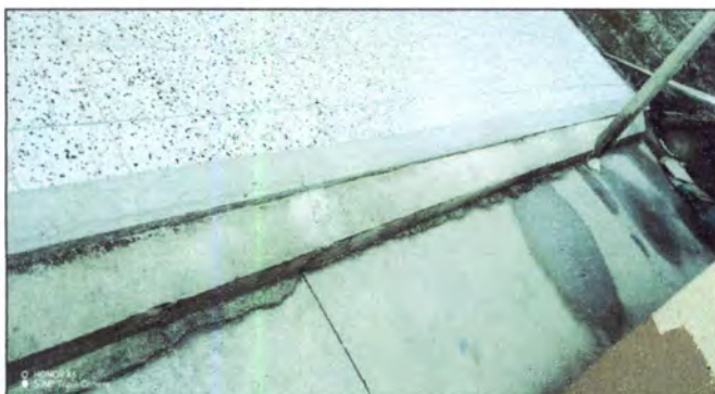
Foto 51: Reparación de plancha de concreto de patio al lado de la cocina dejando un desnivel para que no se acumule el agua y quitar cimiento de concreto de un tubo de agua de canales que no deja fluir de agua.
