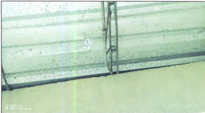
Foto 3: Sustitución y compra de 4 láminas de 10 pies calibre 26 troquelada Aluzinc, una en techo del pasillo de gradas segundo nivel, una en pasillo del segundo nivel, frente al aula de quinto primaria, una por dentro de las
