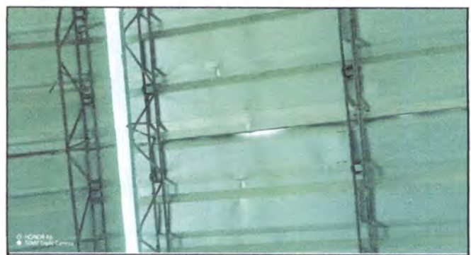
Foto 6: Sustitución y compra de 4 láminas de 10 pies calibre 26 troquelada Aluzinc, una en techo del pasillo de gradas segundo nivel, una en pasillo del segundo nivel, frente al aula de quinto primaria, una por
