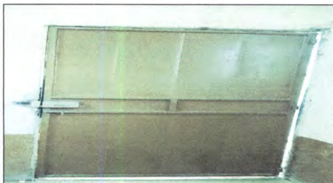
Foto 15: Mantenimiento de puerta de metal de cocina (lijado, cepillado, aplicación de pintura anticorrosiva).
