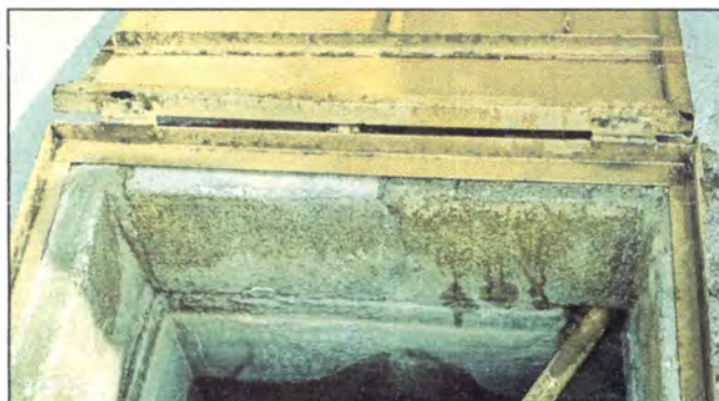
Foto 64: Quitar y colocar la sustitución de tapadera de metal para la cisterna y rejilla de metal en el patio principal.
