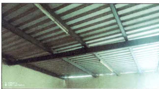
Foto 12: Mantenimiento de costaneras incluyendo lijado, aplicación de anticorrosivo y pintado en el techo de cocina.
