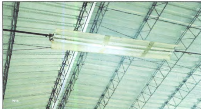
Foto 55: Se cambian lámparas tipo led en el pasillo en frente, 4 lámparas led pasillo de gradas segundo nivel 1 lámpara, pasillo del segundo nivel 3 lámparas) y limpieza de base y colocación de tres balastos.
