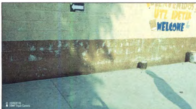
Foto 27: pintar el sócalo en baños de niños, niñas, baño de preparatoria, cocina y en muro perimetral con pintura impermeabilizante.
