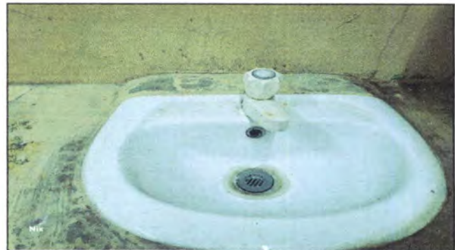
Foto 40: Quitar 4 lavamanos en mal estado (dos de los baños de niños y dos de los baños de niñas) comprar 4 lavamanos nuevos con sus accesorios e instalación de los nuevos lavamanos con tubería y drenaje.
