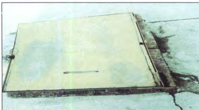
Foto 63: Quitar y colocar la sustitución de tapadera de metal para la cisterna y rejilla de metal en el patio principal.
