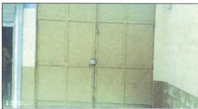
Foto 48: Mantenimiento de portón de metal de cuatro puertas de la calle principal (lijado, cepillado y pintado con pintura anticorrosiva de los dos laterales) y cambio de chapa Yale.
