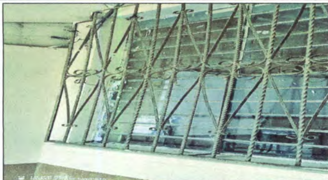
Foto 19: Mantenimiento de un balcón en la clase de segundo primaria con medida de 6 metros cuadrados y un balcón en la bodega vespertina con cuatro metros cuadrados en la planta baja. Lijado, cepillado, aplicación de pintura anticorrosiva, soldar piezas de adorno sueltas.
