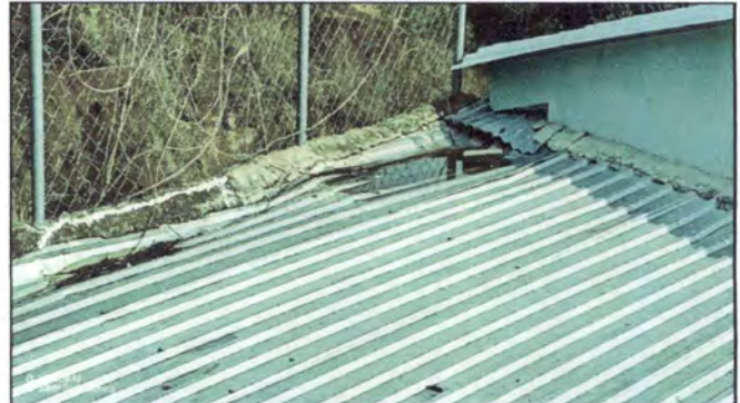
Foto 2: Desmontar el techo completo de lámina de la cocina, compra e instalación de 8 láminas de 18 pies calibre 26 troquelada Aluzinc en techo de cocina
