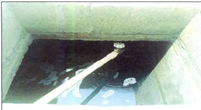
Foto 49: Sustitución de tubería principal, realizar unión de tubería que viene de la calle hacia cisterna, con unión a bomba principal de la escuela 2.5mts de tubo de media y colocación de cheques y llave de compuerta, utilizando dos tubos de media, pegamento, adaptadores, teflón, 10 codos de media y 5 uniones.
