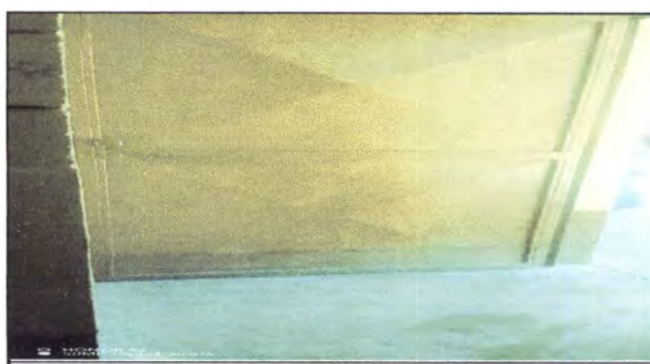
Foto 30: Mantenimiento a estructura (lijado, cepillado, aplicación de pintura anticorrosiva) a 6 puertas de servicios sanitarios.
