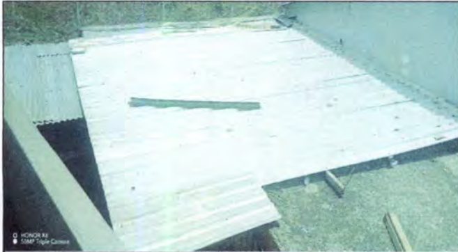
Foto 1: Desmontar el techo completo de lámina de la cocina, compra e instalación de 8 láminas de 18 pies calibre 26 troquelada Aluzinc en techo de cocina
