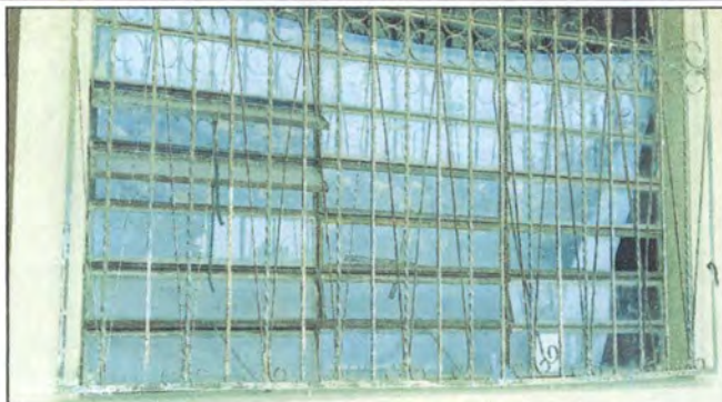
Foto 20: Mantenimiento de un balcón en la clase de segundo primaria con medida de 6 metros cuadrados y un balcón en la bodega vespertina con cuatro metros cuadrados en la planta baja. Lijado, cepillado, aplicación de pintura anticorrosiva, soldar piezas de adorno sueltas.
