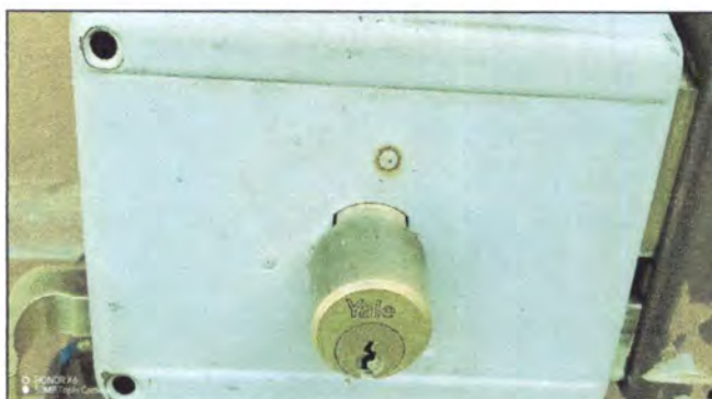
Foto 16: Cambio de chapa Yale a puerta de quinto primaria por mal estado.
