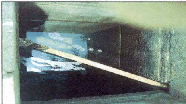
Foto 62: Limpieza y pintar con impermeabilizante la superficie de la cisterna de concreto en el patio con medida de 4x3.6mts y colocación de flote.
