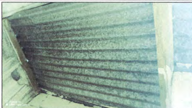
Foto 14: Cambio de estructura de madera por 3 costaneras de metal en el baño de preparatoria.
