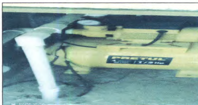
Foto 65: Desmontar e instalar bomba de agua 1/2 hp con sus accesorios y conectarla a la cisterna. Comprar bomba de agua 1/2 hp con sus accesorios de instalación y
