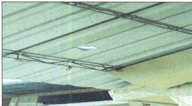
Foto 9: Sustitución y compra de lámina de 12 pies calibre 26 troquelada aluzic, en el techo de bodega de la jornada vespertina por mal estado.
