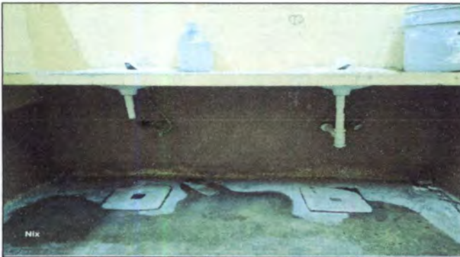
Foto 39: Quitar 4 lavamanos en mal estado (dos de los baños de niños y dos de los baños de niñas) comprar 4 lavamanos nuevos con sus accesorios e instalación de los nuevos lavamanos con tubería y drenaje.
