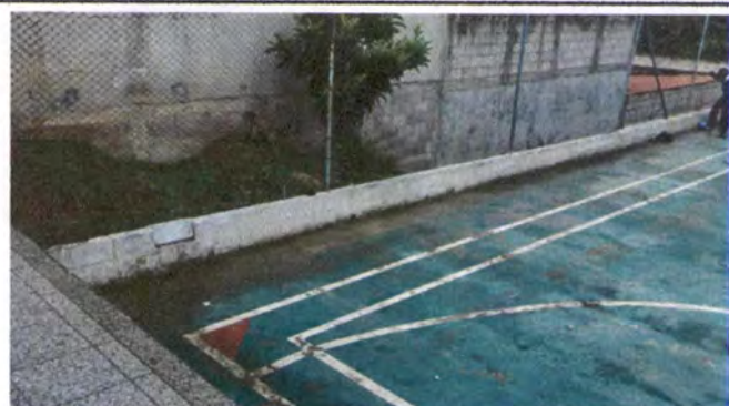
Foto 2: Continuacion de muro con 3 hiladas de blokc mas malla.
