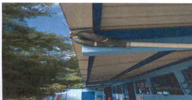
Foto 3: Reparacion de canales.
