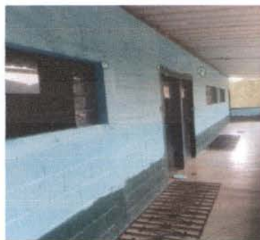
Foto 14: AULAS DEL SEGUNDO NIVEL
