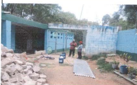
Foto 6: PARTE DE ADENTRO EN PROCESO DE PINTADO
