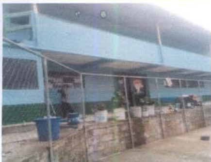
Foto 13: VISTA DE AULAS DEL PRIMER NIVEL
