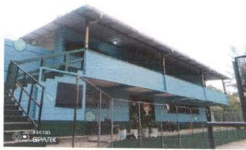
Foto 4: VISTA DE LA ESCUELA
