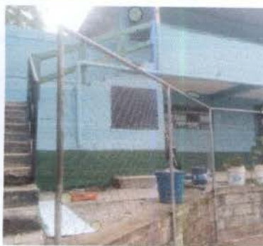
Foto 3: PARTE DEL PRIMER NIVEL YA PINTADO
