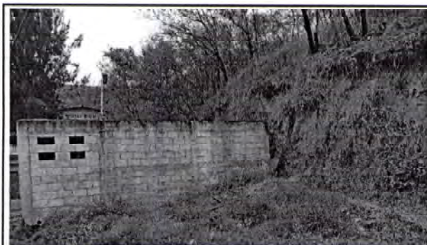
Foto 11: Pintura paredes exteriores
