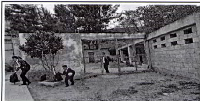
Foto 9: Pintura paredes exteriores
