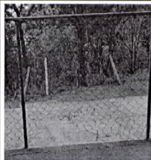
Foto 16: Cambio de malla
