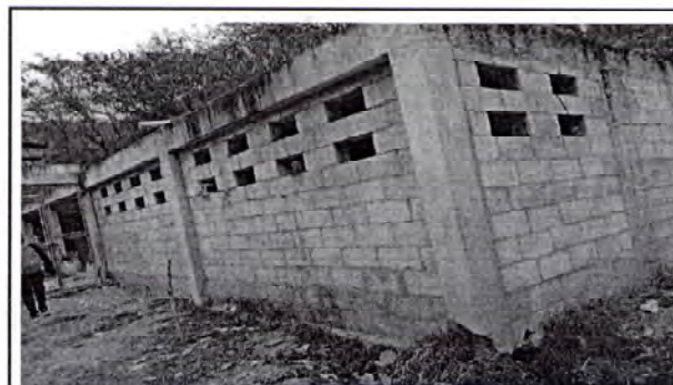
Foto 10: Pintura paredes exteriores
