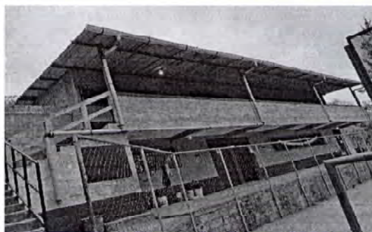
Foto 4: Pintura paredes exteriores
