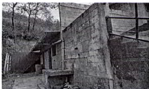
Foto 3: Pintura paredes exteriores
