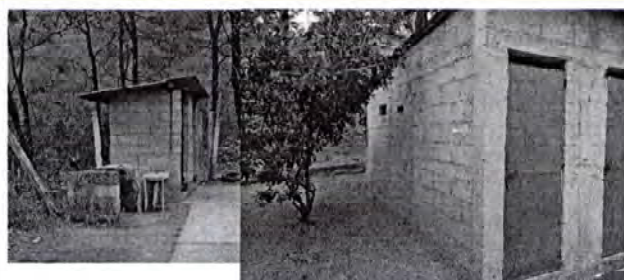
Foto 5: Pintura paredes exteriores
