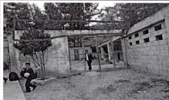
Foto 14: Ampliación de muro
