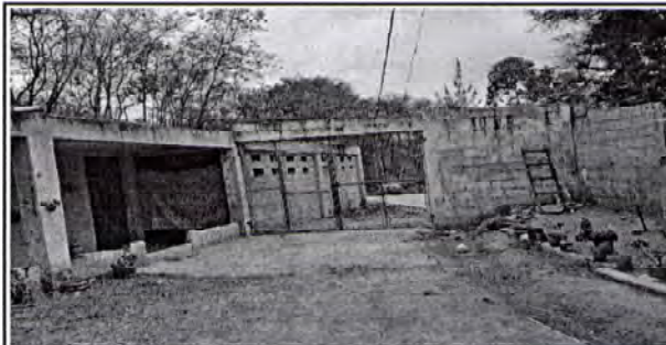
Foto 6: Pintura paredes exteriores
