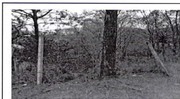
Foto 12: Colocación de postes y malla
