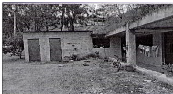
Foto 8: Pintura paredes exteriores
