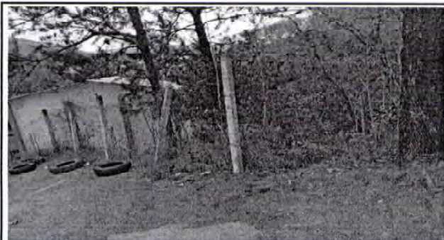
Foto 13: Colocación de postes y malla
