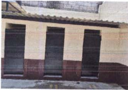
Foto 7: Sanitarios, cambio de techo colocacion de costaneras, mantenimiento de puertas y pintura de paredes.
