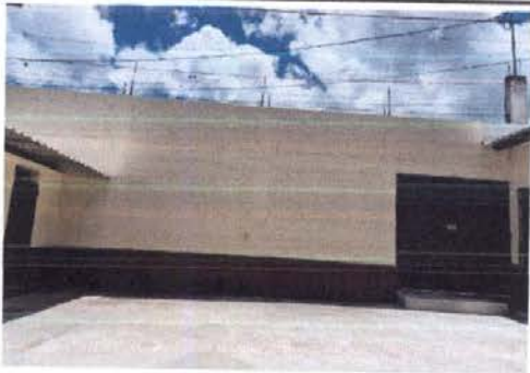
Foto 15: Pintura de muros exteriores, mantenimien de porton.
