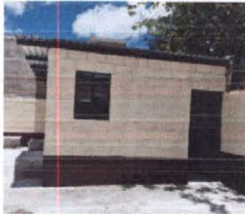
Foto 4: Salon 3. Cambio de techo, mantenimiento de costaneras, colocacion de pisos y ventanas.
