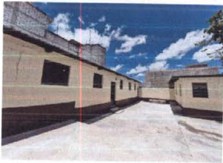
Foto 14: Pintura de salones paredes exteriores.
