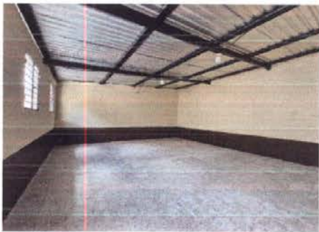
Foto 2: Salon 2 cambio de techo, colocación de piso, mantenimiento de costaneras.
