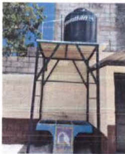
Foto 11: Instalación de tinaco de 1100 litros.
