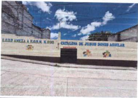
Foto 13: Pintura de muros exteriores
