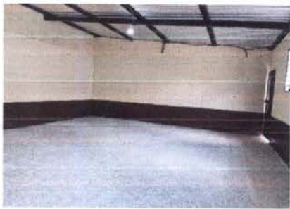
Foto 1: Salon 1 cambio de techo, colocación de piso, mantenimiento de costaneras.
