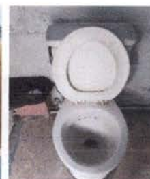
Foto 4: Inodoro que debe sustituirse, debido a su mal estado. (Panorama interior sanitario).
