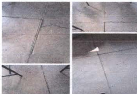
Foto 2: Torta de cemento, Salón 2. (Este salón presenta levantamiento en su estructura). (Ángulo centro del salón)
