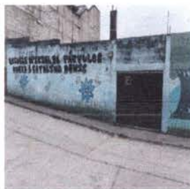
Foto 4: PINTURA PAREDES INTERIORES Y EXTERIORES.
