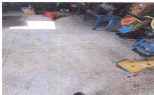
Foto 3: Torta de cemento, Salón 3. (Este salón presenta levantamiento en su estructura). (Ángulo centro del salón)
