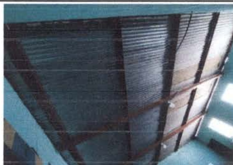
Foto 4: TECHO (ESTRUCTURA Y LÁMINA) SALON 2 - (Vista desde ángulo sur del salón)
