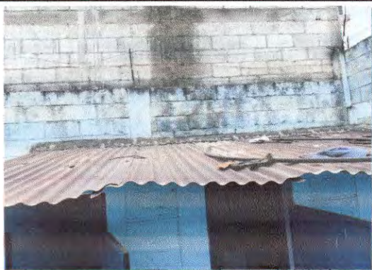
Foto 9: Modulo de Baños, se observa el mal estado de la estructura de soporte y lamina
