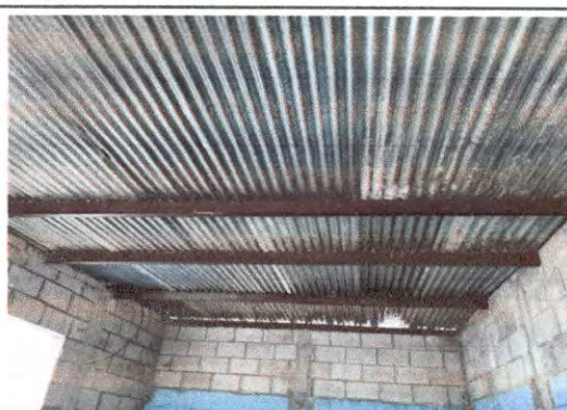
Foto 6: Modulo 2, se observa el mal estado de la lamina y la estructura de soporte necesita mantenimiento
