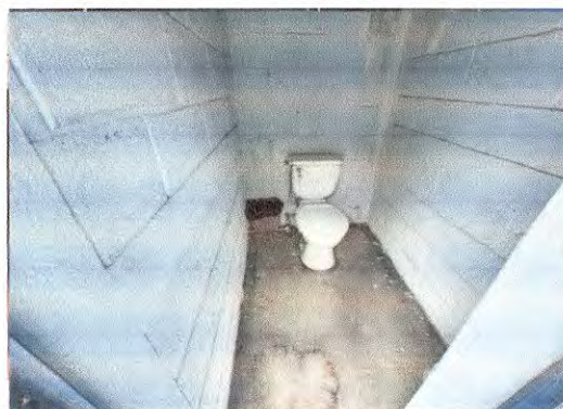
Foto 10: Se observa sanitario en mal estado, así mismo es necesario colocar azulejo en muros y pintura
