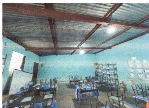
Foto 4: Modulo 1, se observa el mal estado de la lamina y la estructura de soporte necesita mantenimiento
