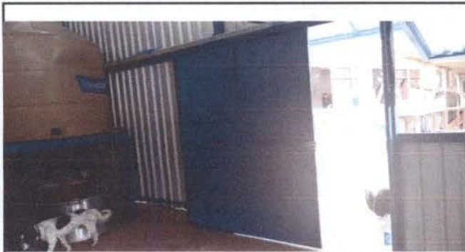
Instalacion de puerta corrediza doble hoja
