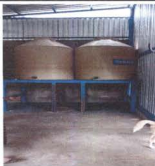
Instalacion y colocacion de 2 tinaos 2,500 litros
