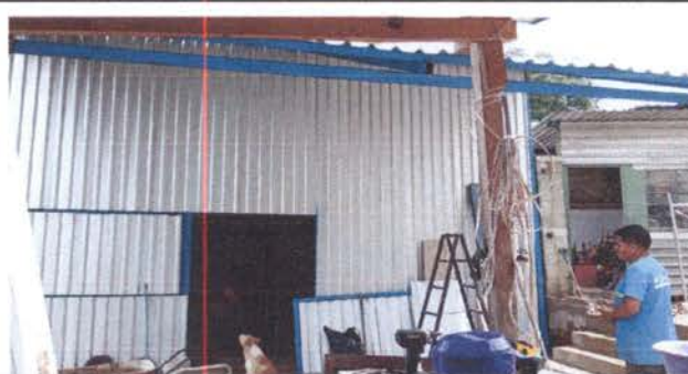
Finalizacion de estructura, colocacion de cubierta y techo con laminas troqueladas
