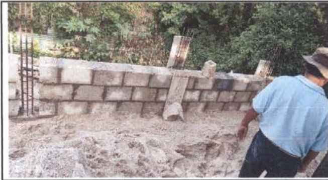
Rellenado y compactado de contrapiso y nivelando el muro de contencion
