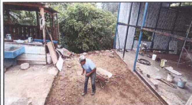
nivelacion y compactado para torta de patio previo
