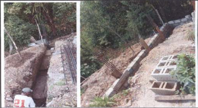
zanjeo de cimient y zapata y levantamiento de muro de muro de contencion
