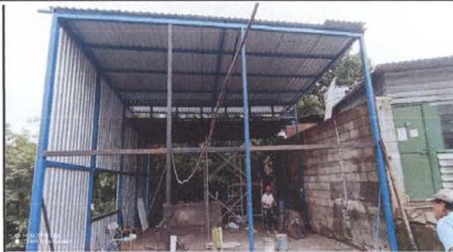
Techo y cubierta instalacion y estructura
