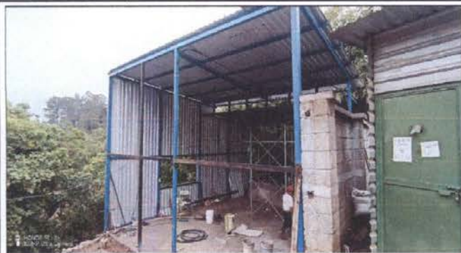
Instalacion de cubierta y techo
