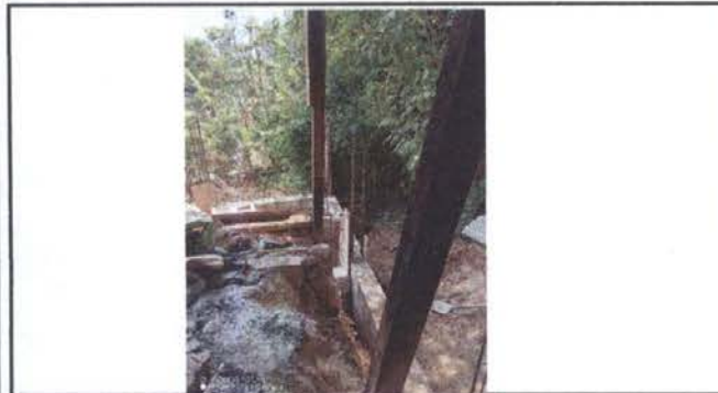
Levantamiento de muro de contencion
