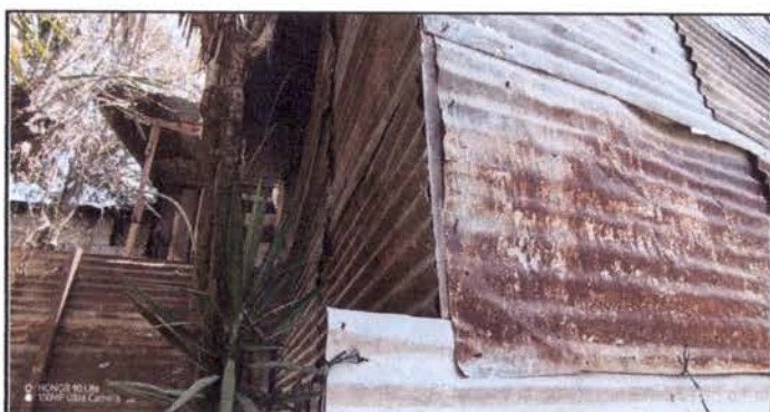
CUBIERTA DE LAMINA ACANALADO
