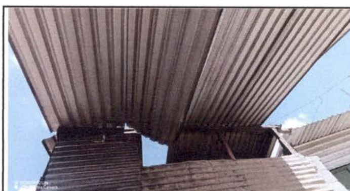
Foto 4: TECHO DE LAMINA
