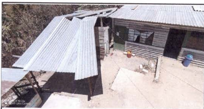
PARTE SUPERIOR DE TECHADO
