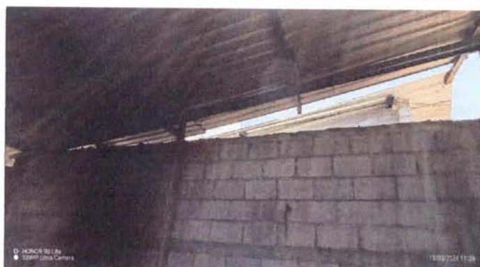
MURO A REPELLAR Y LIMPIAR 32 M2
