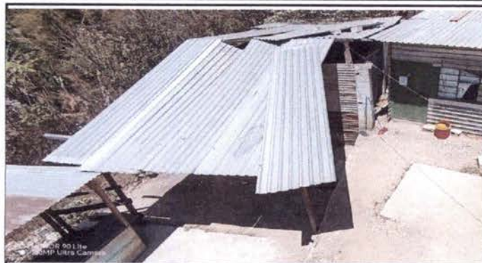
Foto1: TECHO DE COCINA
