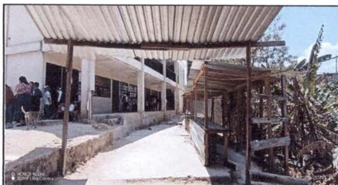
Foto 3: ESTRUCTURA DE MADERA
