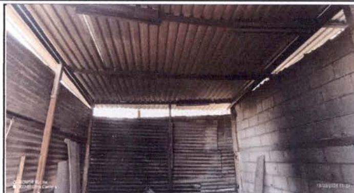
Foto 2 ESTRUCTURA DE MADERA
