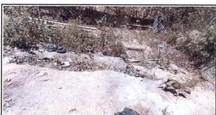
EXTERIOR DE COCINA NORTE
