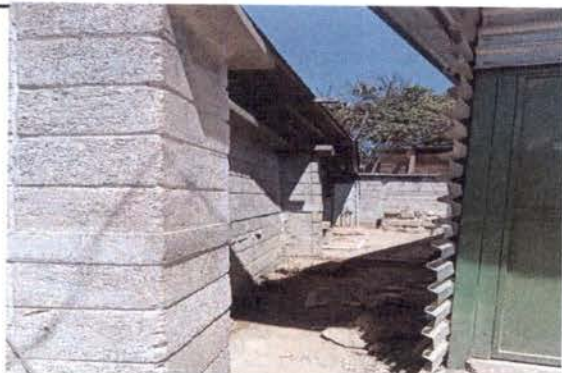
MURO DE COCINA
