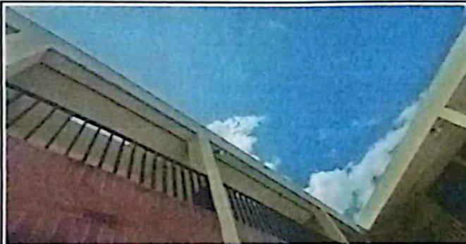
Foto 3: PASILLO; SE OBSERVA EL 100% DE LOS TRABAJOS DE INSTALACIÓN DE REFLECTOR 100 WATTS.
