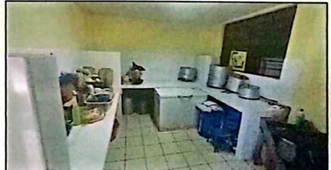
Foto 4: COCINA; SE OBSERVA EL 100% DE LOS TRABAJOS DE INSTALACIÓN DE AZULEJO EN TODA LA COCINA H=1.70M. Y LOS TRABAJOS DE MESA DE CONCRETO AL 100%
