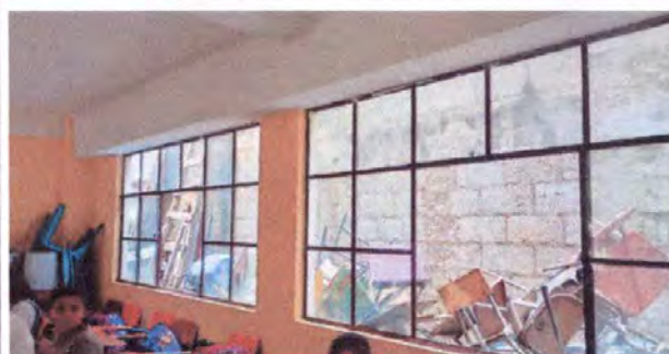
Foto 2: colocar balcones no. 5
