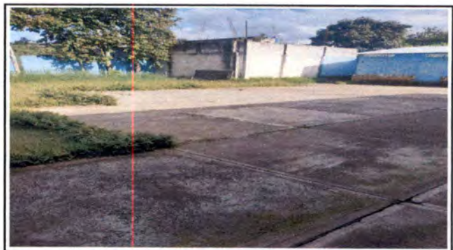
Foto 4: Situación previa a pavimentar el patio.
