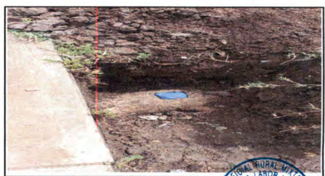
Foto 6; Se dejará preparado el drenaje para continuarlo.
