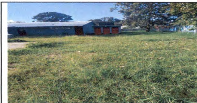
Foto 5: Situación previa a Pavimentar el patio.
