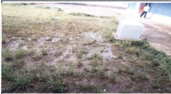
Foto 1; Situación previa al pavimento.
