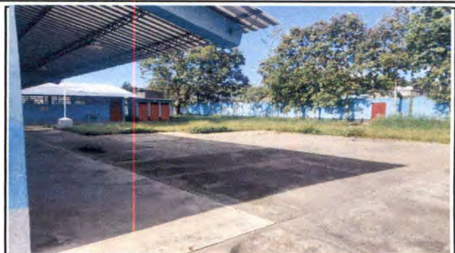
Foto 2; Remozamiento del pavimento de la escuela.
