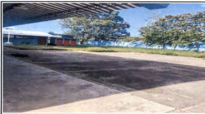
Foto 3: Situación actual del pavimento.
