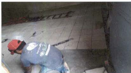
Foto 7: Instalación de piso cerámico
