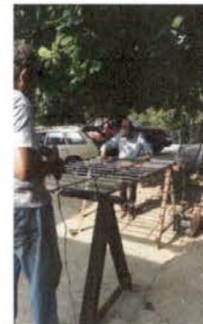
Foto 4: fabricación de balcones.
