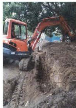
Foto 8: construcción de muro perimetral
