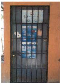
Foto 9: puerta de Reja ya instalada
