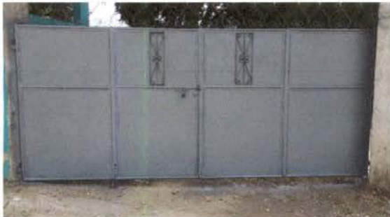
Foto 3: Reparación portón principal.
