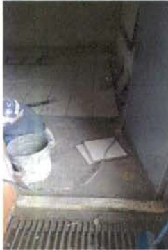
Foto 1: instalación de piso.
