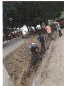
Foto 10: construcción muro perimetral
