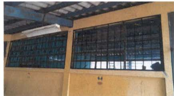
Foto 6: Balcón ya instalados.
