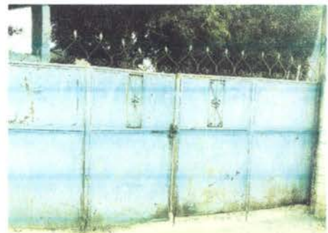
Foto 20: REPARACIÓN Y MANTENIMIENTO DE PORTÓN PRINCIPAL
