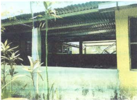
Foto 17: COLOCACIÓN DE BALCÓN EN BODEGA
