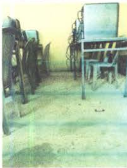
Foto 11: COLOCACIÓN DE PISO CERÁMICO EN LABORATORIO
