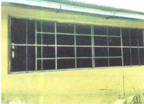
Foto 15: COLOCACIÓN DE VIDRIOS EN AULA N°9
