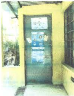
Foto 9: COLOCACIÓN PUERTA DE REJA EN LABORATORIO
