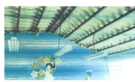
Foto 24: REPARACIÓN DE LÁMPARAS
