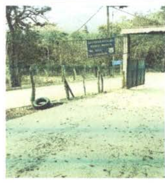
Foto 22: LEVANTADO DE MURO PERIMENTAL
