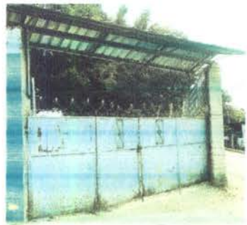
Foto 19: REPARACIÓN Y MANTENIMIENTO DE PORTÓN
