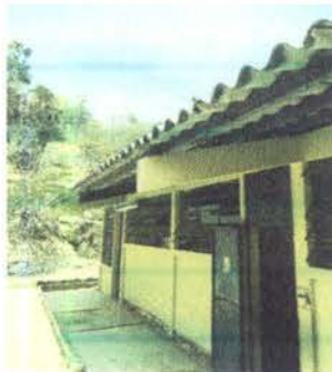
Foto 5: COLOCACIÓN DE CANAL CON BAJADA
