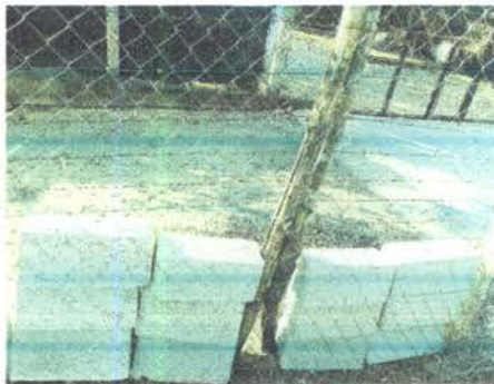
Foto 3: CONSTRUCCIÓN MURO PERIMETRAL
