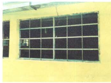
Foto 16: COLOCACIÓN DE VIDRIOS EN AULA N°9
