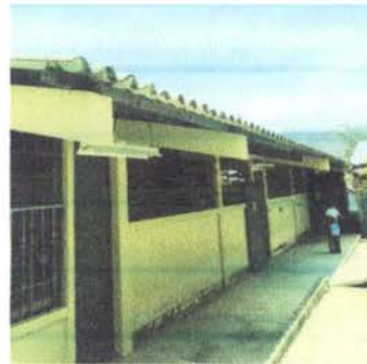
Foto 6: COLOCACIÓN DE CANAL CON BAJADA
