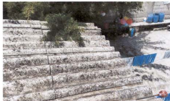
Fotografía 8: Se observa lamina de tipo fibra cemento.
