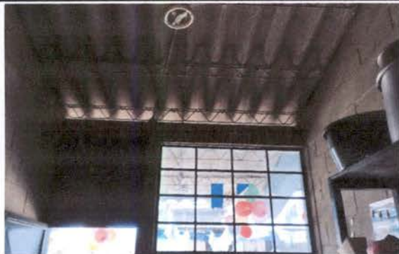
Fotografía 7: Se observa en la imagen con estructura portante de joist y lamina de fibrocemento.
