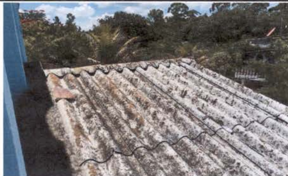
Fotografía 6: Imagen que muestra el techo de fibrocemento sobre el ambiente de cocina.
