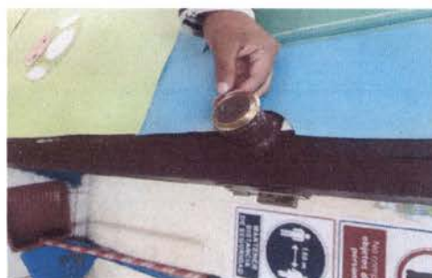
Foto 6: sustitución de chapa en salón de clase
