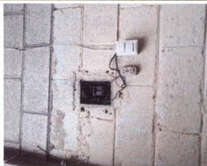
Foto 8: sustitución de tablero de flipones.
