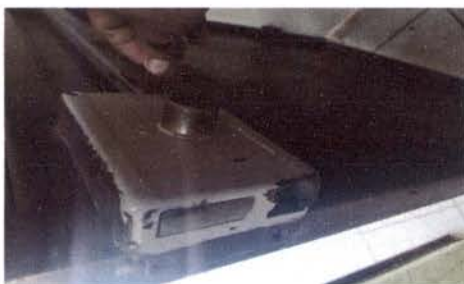
Foto 11: sustitución de chapas en puertas de metal
