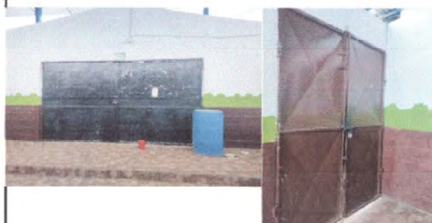
foto 4. Reparacion y mantenimiento de portones
