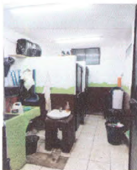
Foto1: Mejoramiento de sanitarios
