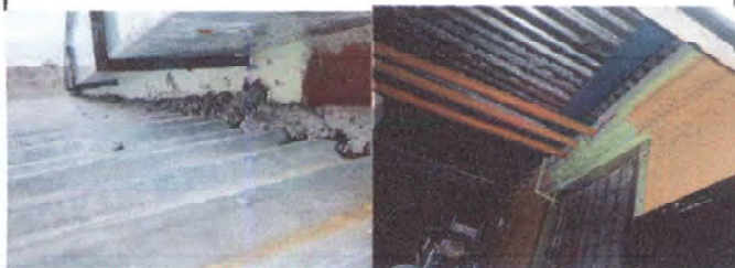
foto 5. Filtracion de agua por abertura entre lamina y muro
