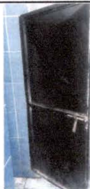
Mantenimiento de estructura
