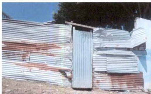
Sustitucion de portón
