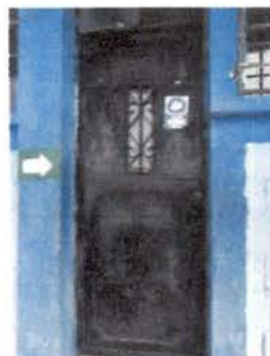
Mantenimiento de Estructura
