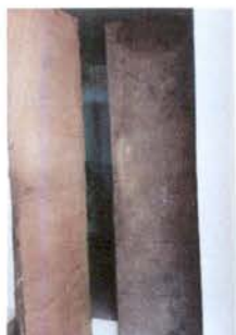
Sustitucion de puerta de bodega
