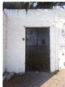
Sustitucion de puerta de entrada
