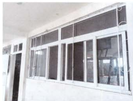
Mantenimiento de balcones
