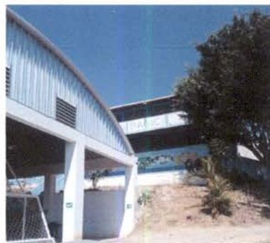
Pintura de muros exteriores
