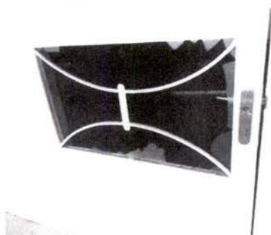
Mantenimiento de Estructura
