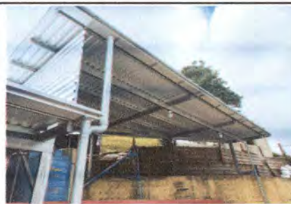
FOTO 6: INSTALACIÓN DE BAJADA DE AGUA PLUVIAL CON TUBO PVC DE 4"
