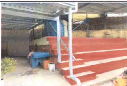
FOTO 5: INSTALACIÓN DE BAJADA DE AGUA PLUVIAL CON TUBO PVC DE 4"
