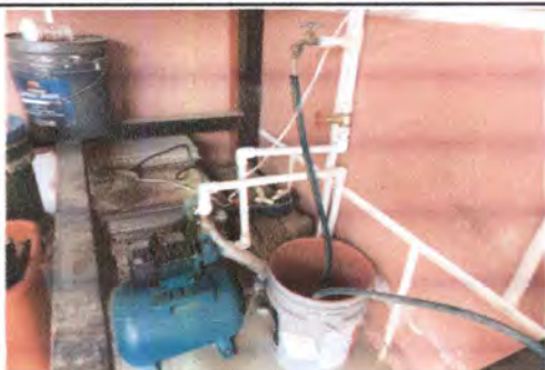
FOTO 7: INSTALACIÓN DE BOMBA DE 1/2 HP
