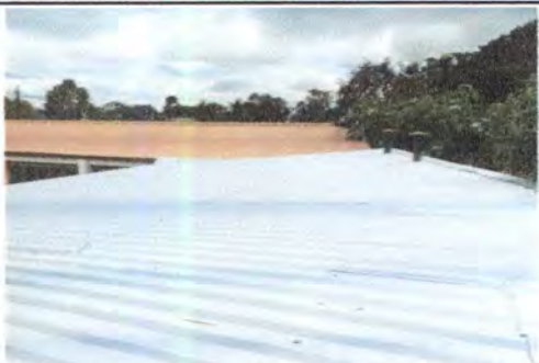
FOTO 1: SUSTITUCIÓN DE LÁMINA POR LÁMINA TROQUELADA CALIBRE 26
