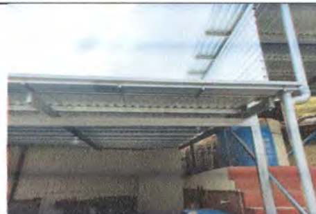
FOTO 4: INSTALACIÓN DE CANAL DE METAL CON PESCANTE
