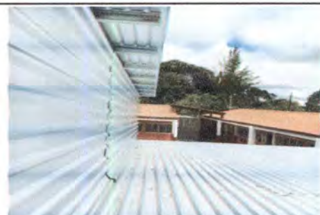
FOTO 3: (TRABAJO EXTRA) INSTALACIÓN DE LÁMINA TROQUELADA CALIBRE 26
