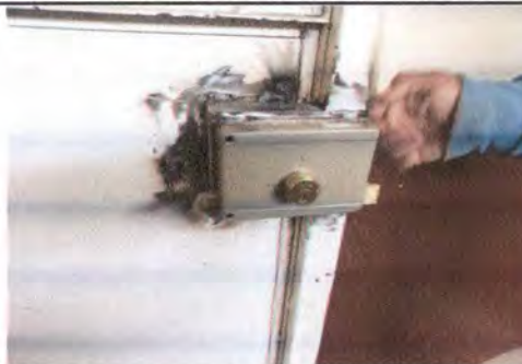
FOTO 8: SUSTITUCIÓN DE CHAPA EN DIRECCIÓN
