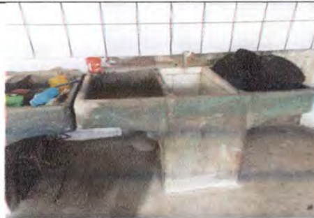
FOTO 10: REPARACIÓN DE PILAS EXISTENTES
