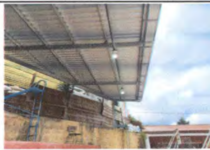
FOTO 12: (TRABAJO EXTRA) INSTALACIÓN DE LÁMPARAS
