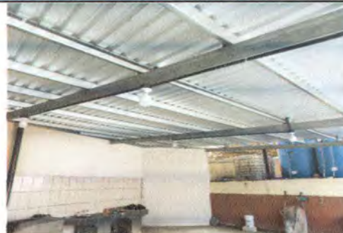
FOTO 2: SUSTITUCIÓN DE ESTRUCTURA DE SOPORTE DE METAL
