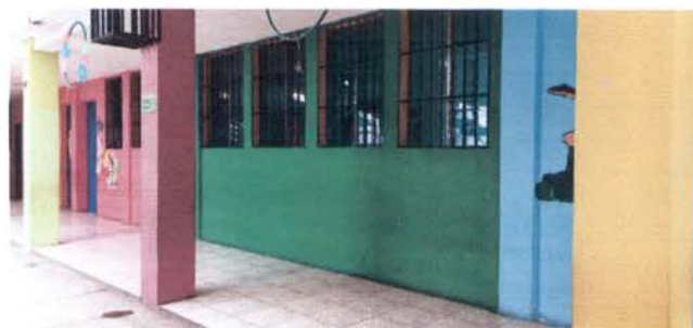
Foto 4: REGLÓN 9; PINTURA EN MUROS EXTERIORES
