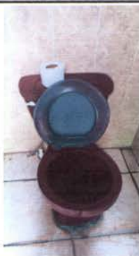
Foto 5: REGÓN 10; SUSTITUCIÓN DE ACCESORIOS INODORO (CONTRA LLAVE, TUBO DE ABASTO Y TANQUE)
