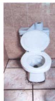
Foto 6: REGÓN 10; SUSTITUCIÓN DE ACCESORIOS INODORO (CONTRA LLAVE, TUBO DE ABASTO Y TANQUE)
